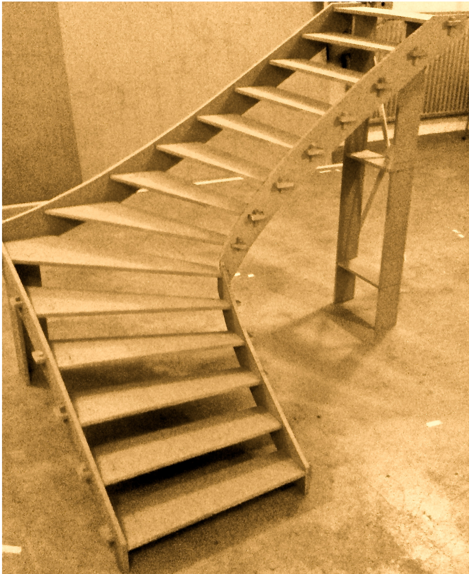
Fig. 39 Trappmodell skala 1:2 uppritad efter mandorlametoden, tillverkad i mdf-board.
