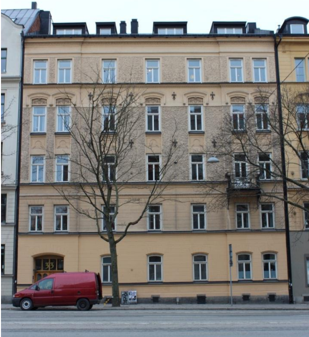
Figur 13. Karlbergsvägen 33's bevarade gatufasad
