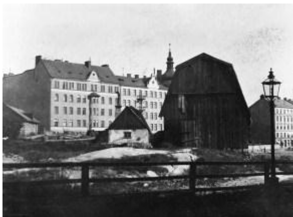
Figur 2. Kvarteret Resedan och Snöklockan under uppförande år 1900.
