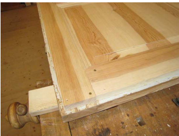
Figur 18 Det nya ramverket skruvas fast på befintlig dörr. Spegelarna kläms fast av ramverket.
