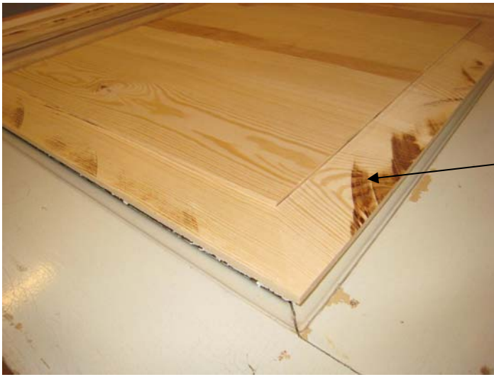
Figur 16 Den nya spegeln har slät undersida och en sågad fris på ovansidan. 10 mm cellplast ligger mellan den gamla och den nya spegeln.
