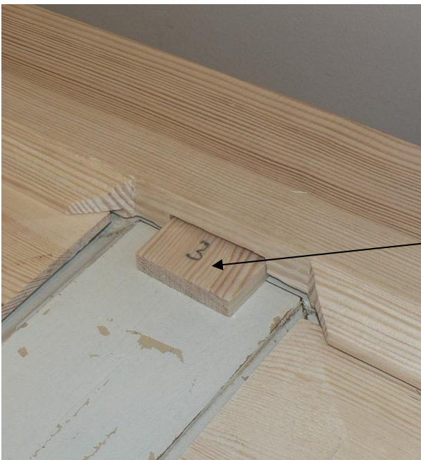
Figur 17 Träklossar infällda i mötet mellan de nya ramverksdelarna.
