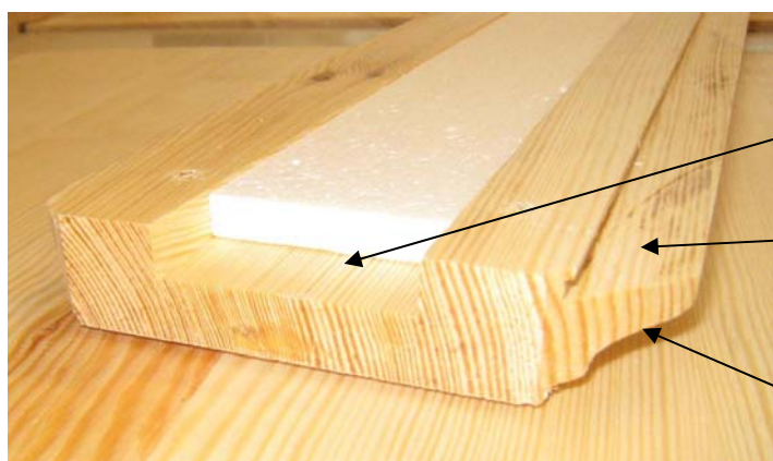
Figur 15 Spår fräst i det nya ramverket.
