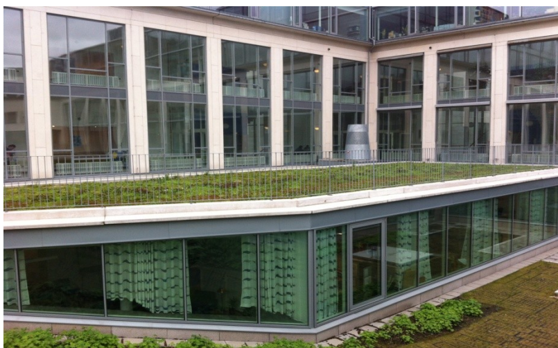
Figur 10: Extensivt grönt tak, Handelshögskolan Göteborg (foto: Sofie Engel)
