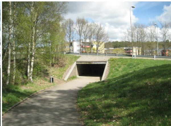
FIGUR 15 GÅNGTUNNEL I LÖVGÄRDET
