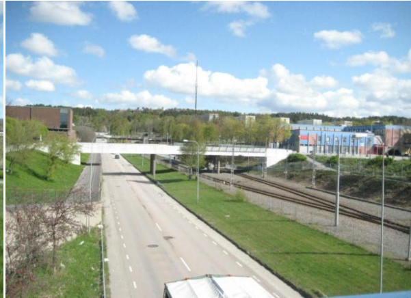
FIGUR 21 BIL- OCH SPÅRVÄG I HJÄLLBO
