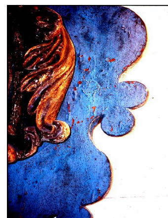
Fig. 16. Spjälkande limfärg
