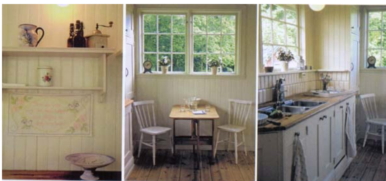
Fig. 2. "...} pärlsponten och köksinredningen är målad i ljus linoljefärg{...} Köksinredningens profil är kopierad efter en lucka från husets skaffereri och kaklet är köpt på Nacka byggnadsvård."
