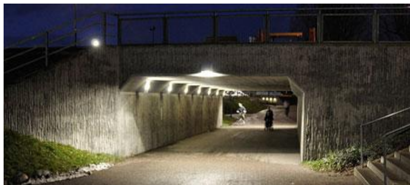
Figur 18, Planskild gång- och cykeltunnel. Källa: Egen
