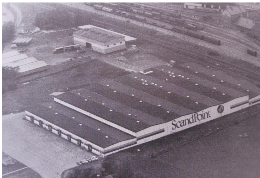
Fig. 5.2 Scand Point i Falköping, med en total lageryta på 17 900 m 2 samt en kontorsyta på 500 m 2 , källa: Scand Points hyresavtal 1982. Källa bild: Nordmark, 1990, s 140
