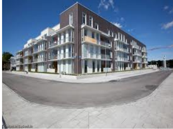
Bild 2: Brf Eriksbergsterassen (www.eriksbergsterassen.se)
