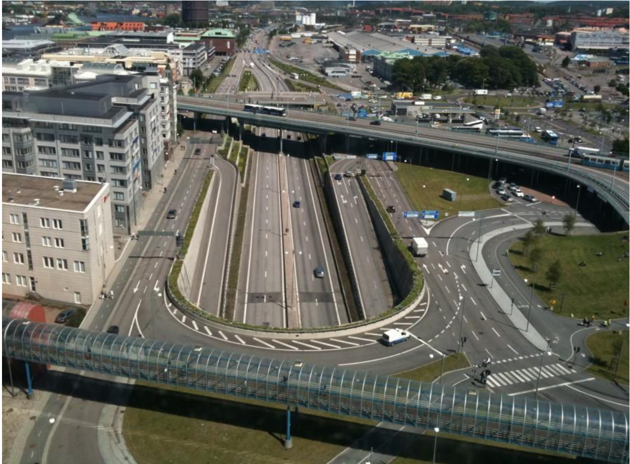
Figur 5.8: Trafikplats vid Götatunnelns norra mynning vid Göta Älvbrons fäste. (Radar)
