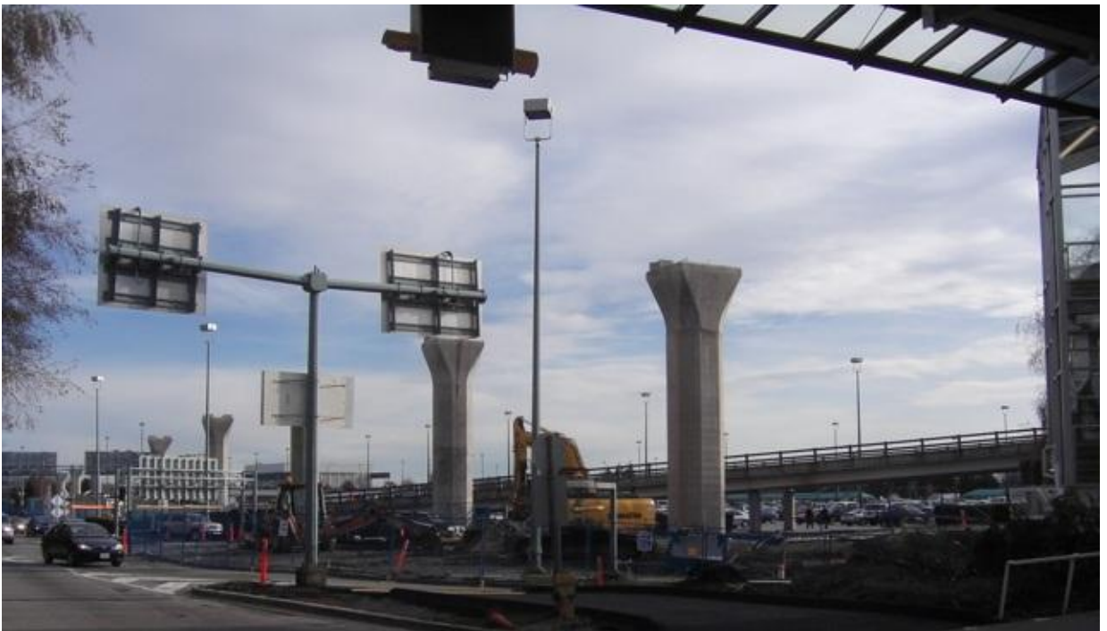
Figur 4.5: Påbörjade pelarkonstruktioner i betong av den andra typen i Vancouver, Canada.
