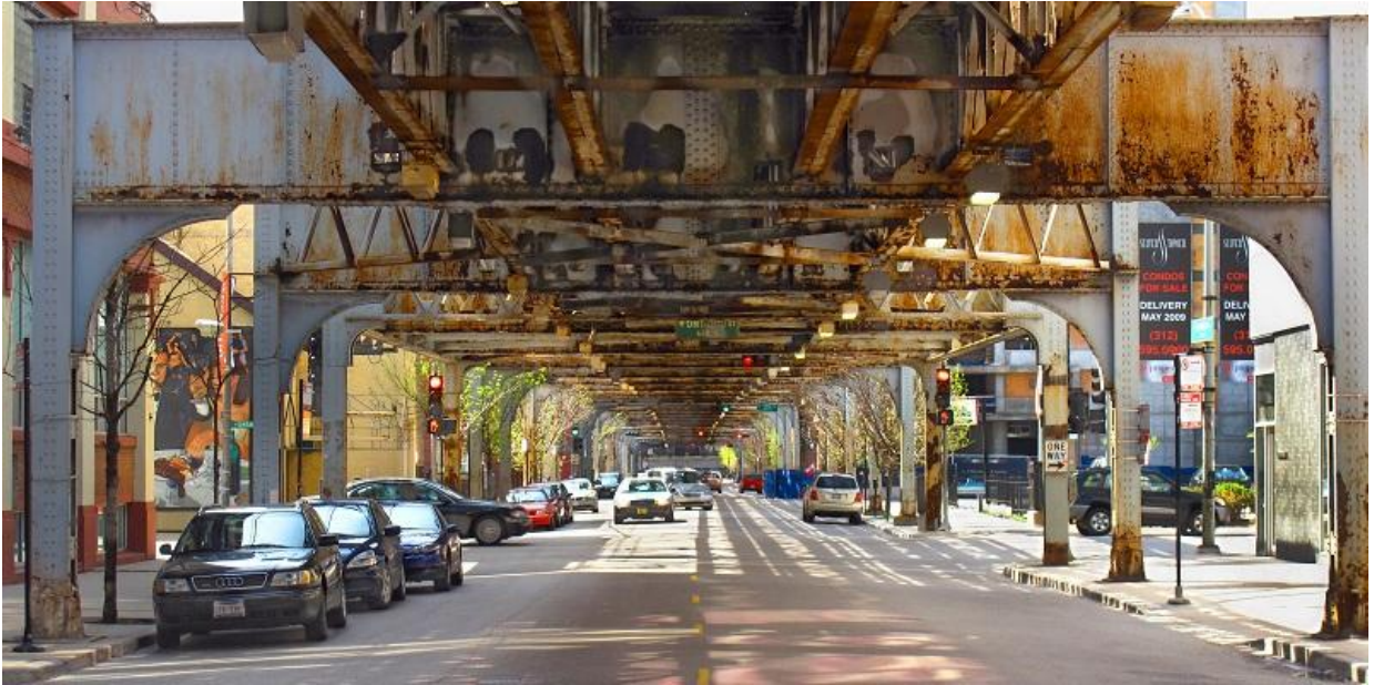
Figur 4.4: Pelarkonstruktioner av stål som återfinns i Chicagos högbana.
