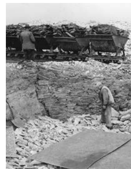
Sättning av kalkugn från en järnvägsvagn. Bilden har erhållits av Lars Magnusson.
