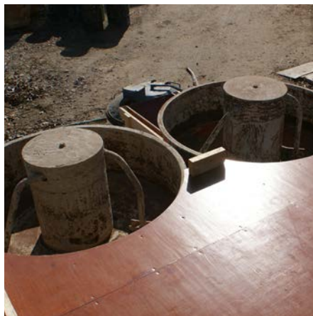
Till vänster: Upparbetningsstationen med två 250-liters tvångsblandare. Framför dem syns sållet.
