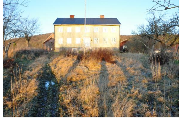
Figur 1, Fristorp gård, husets framsida
