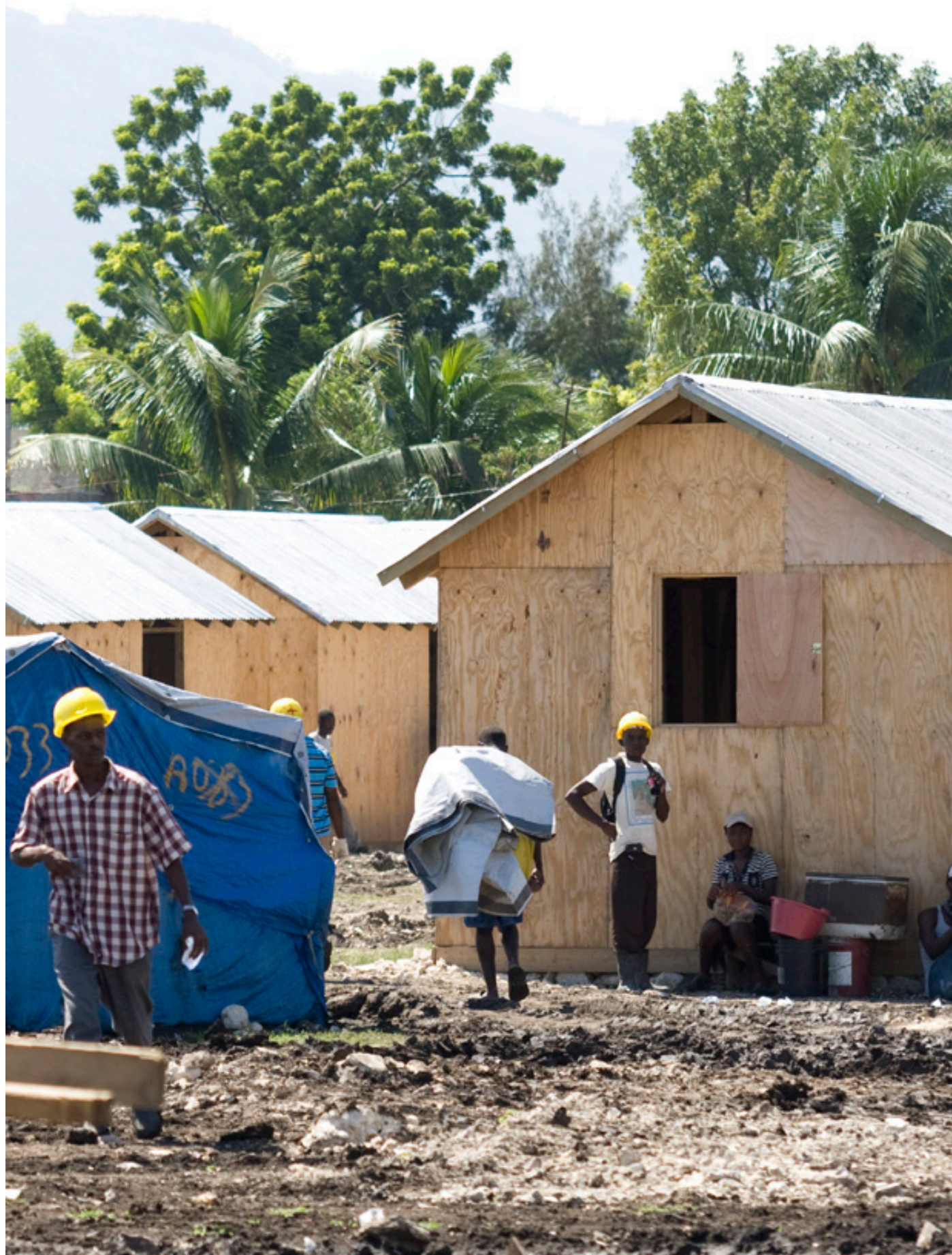
ETT NYTT HEM I LERAN. Arbetare från Annexe arbetar med att bygga övergångsskydd i det gamla träsket.
