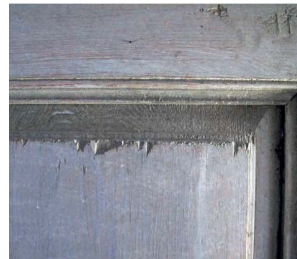
Bild 25 d. Urflisningar på fyllningen.
