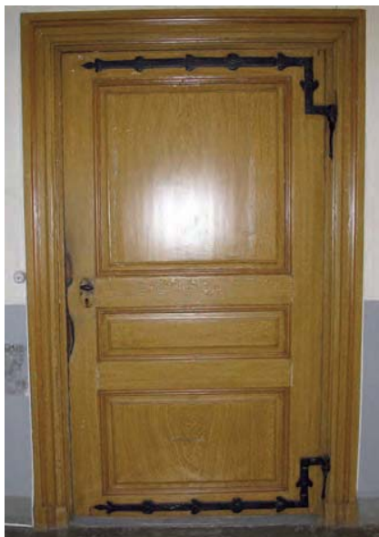
Bild 10. Utbytt dörr i bottenplanet med återanvända beslag.
