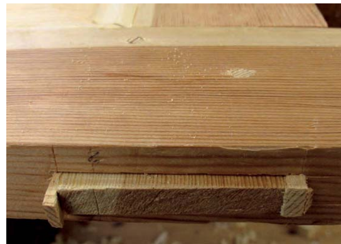
Bild 201. Kilad och pinnad sammansättning.
