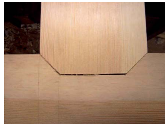
Bild 183. Otäta möten vid möte mellanstycke och sidstycke.
