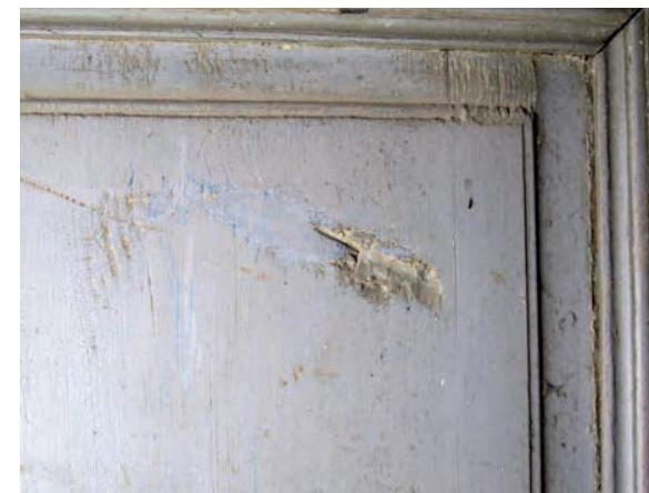
Bild 25 c. Kraftigt urslag runt kvist på fyllningen.
