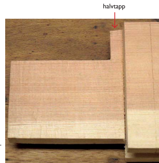
Bild 179. Ytterstycke med den halvtapp som hindrar att ramen dras helt ihop.
