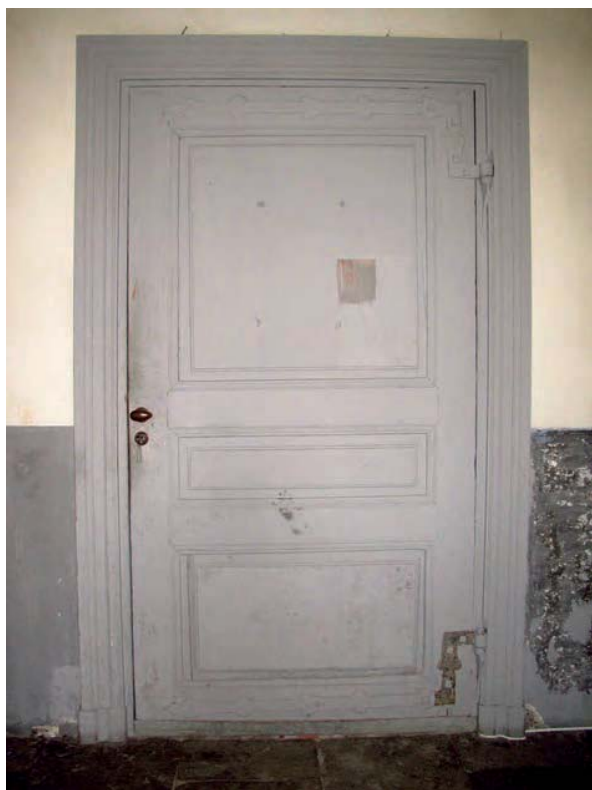
Figur Bild 113. Halvfransk dörr i Nynäs slott med återanvända beslag.
