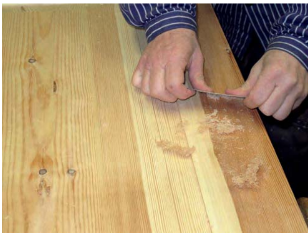
Bild 204. Sickling av dörrbladet.
