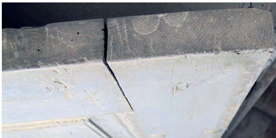
Bild 25 a. Ramen sedd uppifrån med årsringarnas orientering i ett sidstycke.
