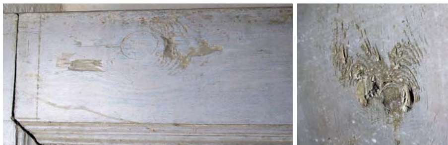
Bild 25 b. Urslag runt kvistar i ramstycken.
