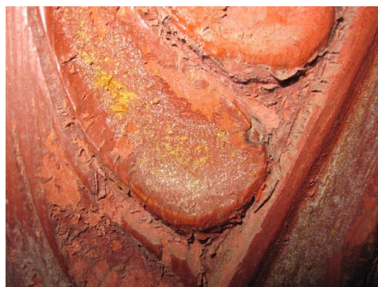
Utfällning på bemålat ornament, prov togs med kisterremsa
