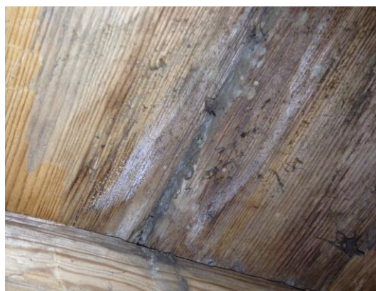
Fig.3. vit utfällning på trärens yta under predikstolen.
