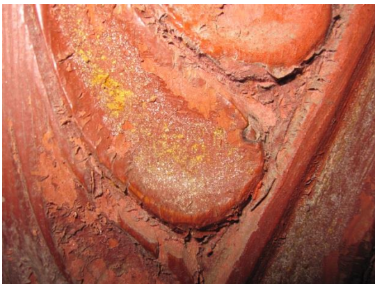
Fig.2. vita korn/ utfällning på bemålat ornament.
