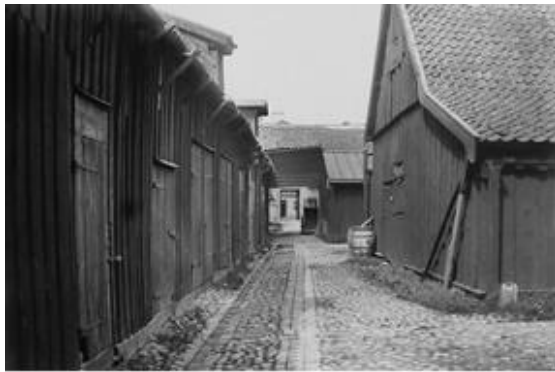
Figur 25: Smedjegatan 42, västra delen av södra gården sedd mot Smedjegatan i norr. 1904.
