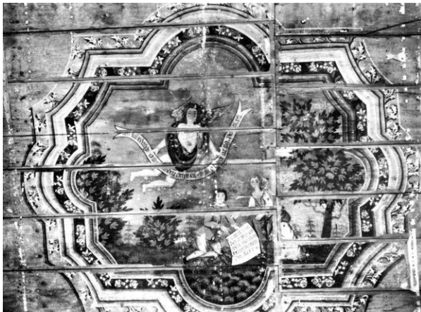
Figur 27: Östra Storgatan 14, Kv. Almen 5. Mittparti av takmålning i huset övertäckt med brädor. Södra rummet. Foto: 1932.
