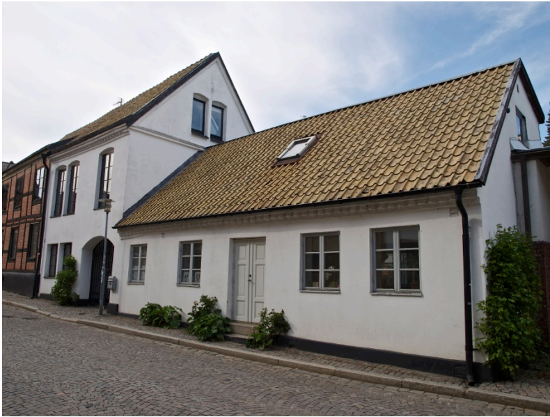
Fig. 10 Strömbergs tillbyggnader. Foto Mattias Eklund 2013
