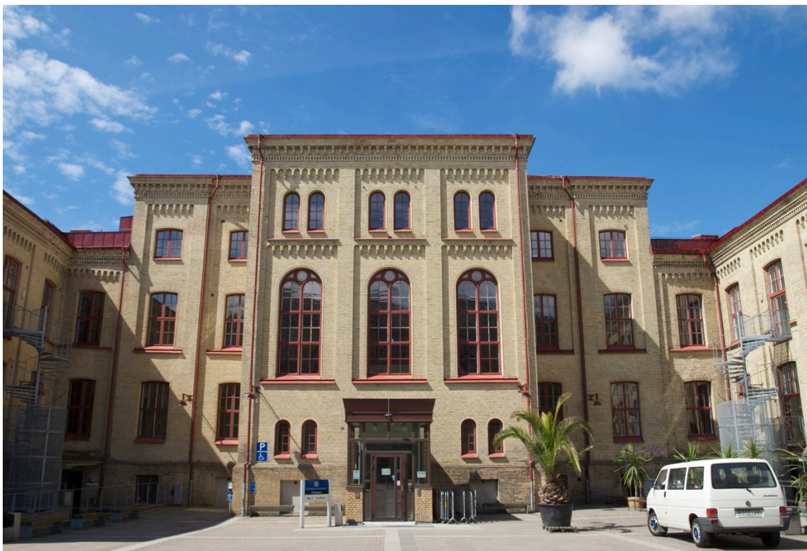
Fig. 15 F.d. Nya Elementarläroverket, nuvarande Pedagogen hus C. Foto Mattias Eklund 2013
