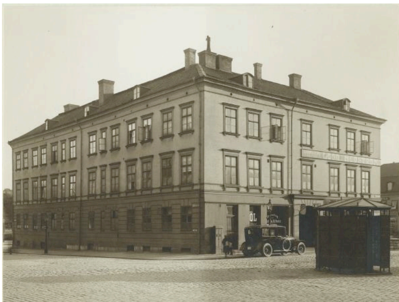
Fig. 4 Henningska huset innan ombyggnationen på 1920-talet. Foto Leon Hedström 1915. Göteborgs stadsmuseum
