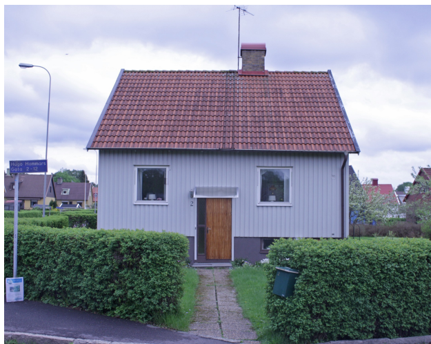
Fig. 3: Ett av de friliggande husen i Kyrkbyn som behållit lockpanelfasaden och tegeltaket. Fönstren är utbytta och det mindre fönstret ovanför entrén har satts igen (jämför ritning nedan).
