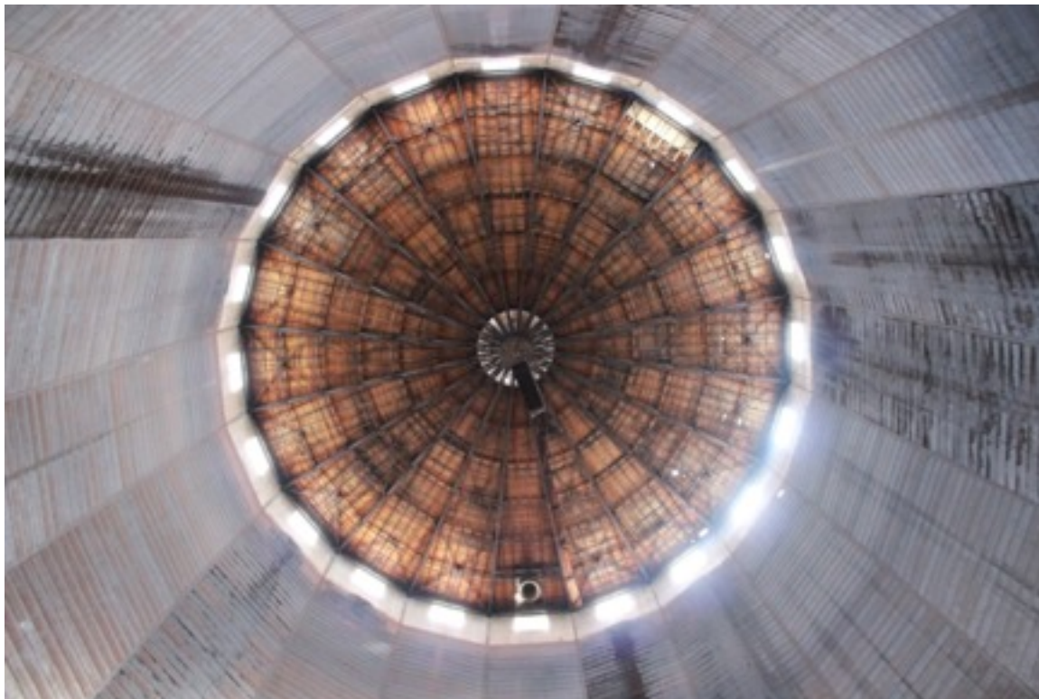
Bild 24.1: Gasklockans takkonstruktion inifrån.
