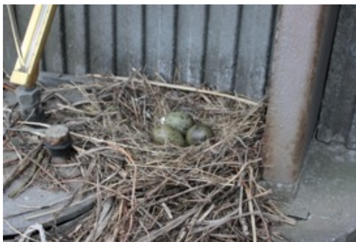
Bild 24.2 överst: En bit av takets bjälklagskonstruktion. Långt till marken. Bild 25 emellan: Dörren till hisstrumman. Bild 26: Måsägg och I-balk.
