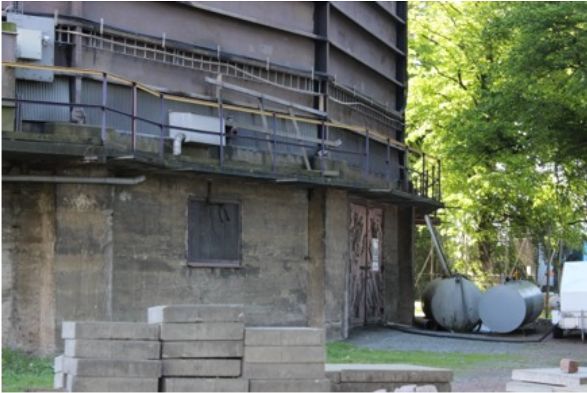
Bild 20: Gasklockans betongfundament med grönskande omgivningar.
