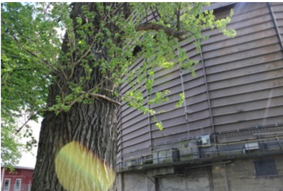
Bild 12 ovan: Månghörningen. T.v syns hisstrumman. Bild 13 nederst: Skymt av gasklockans betongfundament samt de bockade plåtarna som utgör konstruktionens yttre skal.
