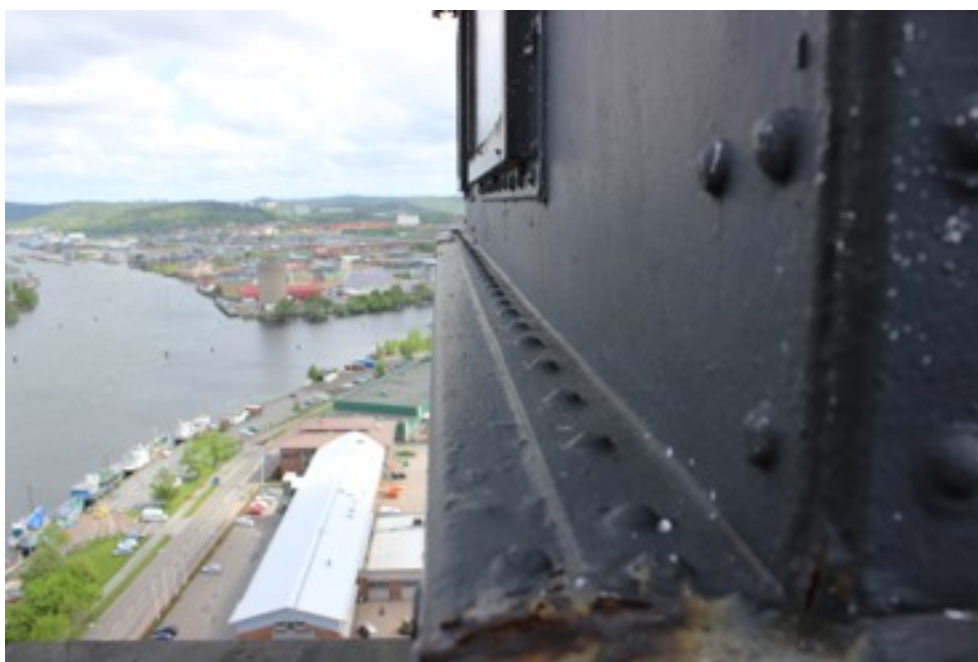
Bild 15: På gasklockans tak, blick mot nordost.
