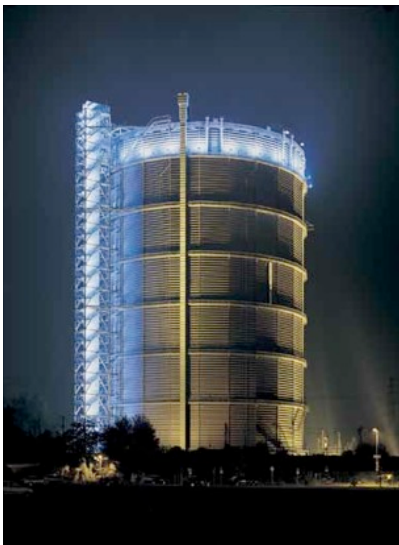
Bild 19: MANNs gasklocka i Oberhausen, samma typ av våtklocka som i Göteborg.
