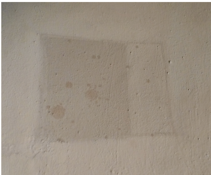
Figur 19. Provyta Hemmesdynge kyrka, västra valvsvickeln. En tredjedel av ytan är rengjord med Akapad-svamp.
