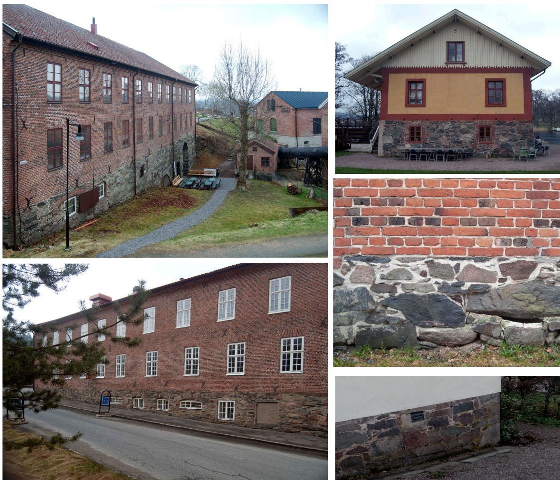
Fig. 12. Byggnader med gråstensmur, uppförda på Nääs och i Tollerød före 1859. Övre fabriken, Mellan-Nääs, Nedre fabriken och stenfoten på stallet. Längst ner till höger syns östra slottsflygelns stenfot, som är murad under 1700-talet.
