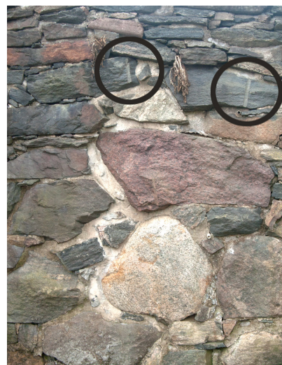
Fig. 11. Till vänster: uttagning i murens insida på ladugårdens övervåning. Till höger: bormärken i murverket inringade. Foto: A. Görander Frost
