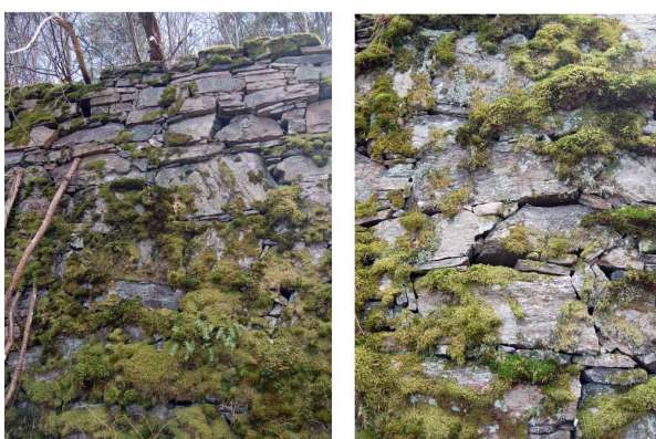
Fig. 17. Kungsvägen och den uppmurade vägbanken från 1850-talet. Foto: A Görander Frost
