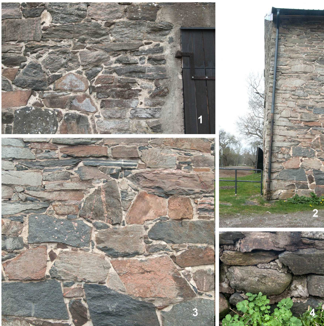
Fig. 10. Murverket. 1. Mindre stenar inklade som skol. 2. Hörnkedjan och den något buktande västra gaveln. 3. Den varierande strukturen och kulören i stenmaterialet vittnar om att stenen inte kommer från ett och samma stenbrott. 4. Enstaka naturligt slipade stenar återfinns i murverket, här i östra logbron.
