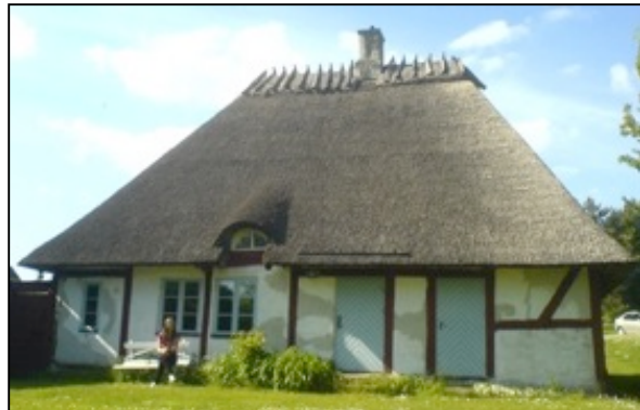
Bild 58. Bara sn. Värbykälla 2011. Mycket har förändrats genom åren. Homejan har en bågformad front, uppståndarna är troligen fler än två och skägget är inslaget parallellt med marken. 52
