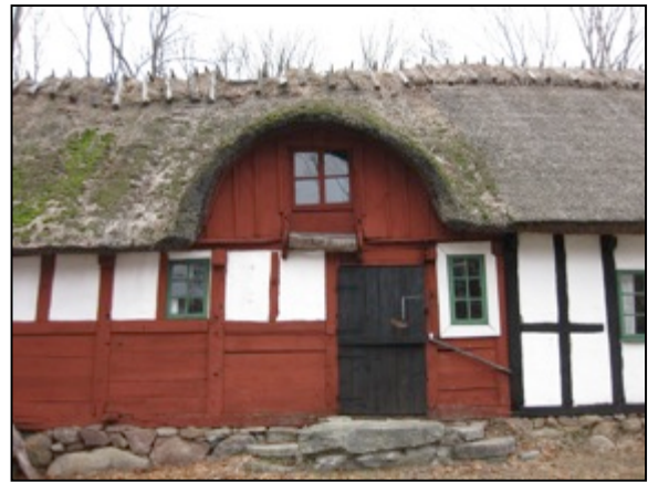
Bild 30. Blåherremölla. Stråtakets som numera är av vass är i gott skick med tanke på dess ålder.
