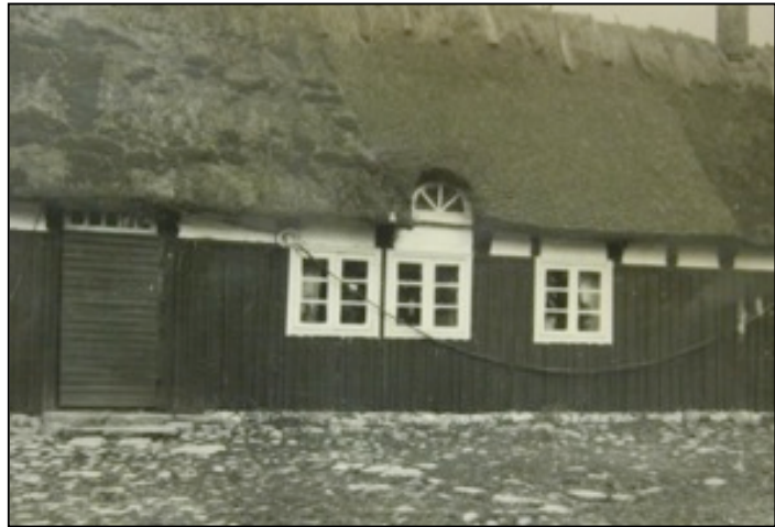
Bild 38. Ö. Strö sn. I Folklivsarkivets gårdsarkiv är detta den vanligast förekommande varianten av Typ 3. Uppståndarna ansluter tidigt till taket pga. homejans låga öppning.
