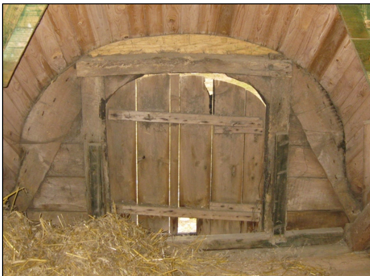
Bild 8. Tryde sn. Sälshög gamlegård. Sidostyckena på fronten är troligen ramsågade och bredden på sidostyckena varierar från 20 cm till 8 cm och är 1 ¼" tjock.
