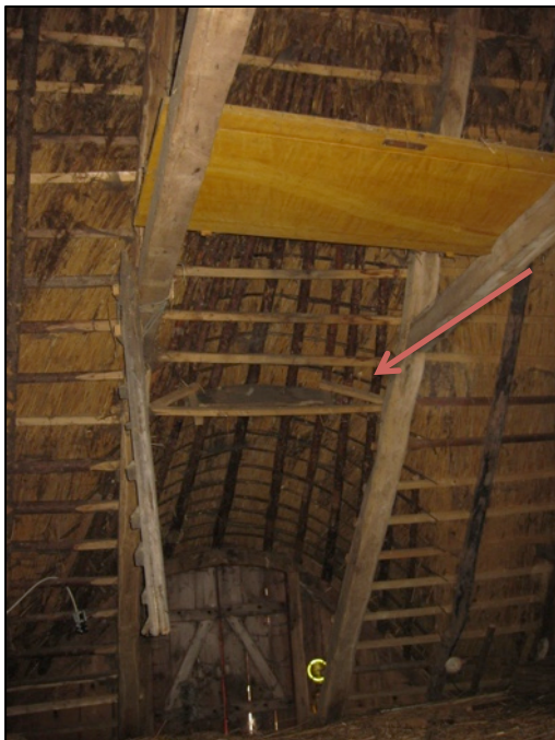
Bild 6. Andrarum sn. Magasinet. Homejan har stabiliserats invändigt med en ram som stabiliserar uppståndarna. Se pil. Denna förändring är gjord vid den senaste omtäckningen, omkring slutet av 1990-talet, eller gången innan det, mitten på 1900-talet.
