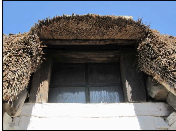
Bild 19. Träskomakarhus från Kirke-Søby. Homejan är endast uppmätt utifrån men det syns att det är två uppståndare som är fästa i överliggaren. På dessa ligger en läktbit som skäggbreda.
