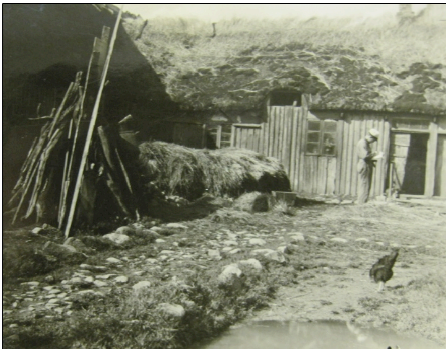
Bild 18. Venneberga sn. Två homejor som liknar homejan på bild 16 har påträffats på en gård från Folklivsarkivets gårdsarkiv. Bilden visar en homeja som saknar lucka eller fönster. Den andra homejan på gården har ett fönster för öppningen. Se bild 60, sida 36 i undersökningsdelen.
