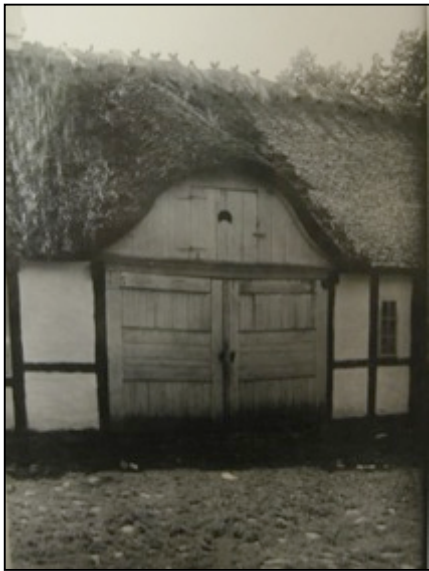
Bild 28. Andrarum. Uppståndarna ser ut att gå hela vägen upp till taknocken. Observera klockformen på fronten.
