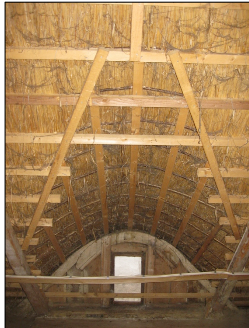
Bild 12. Tomelilla sn. Tomelilla byagård. Homejan är omtäckt med halm men hela takkonstruktionen är utbytt.
