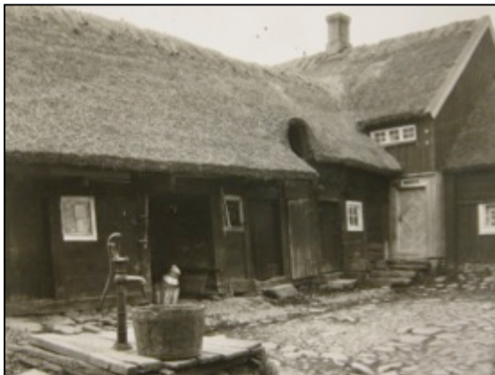
Bild 20. Knislinge sn. Nyttäck halmtak på Austringagården, 1932.
