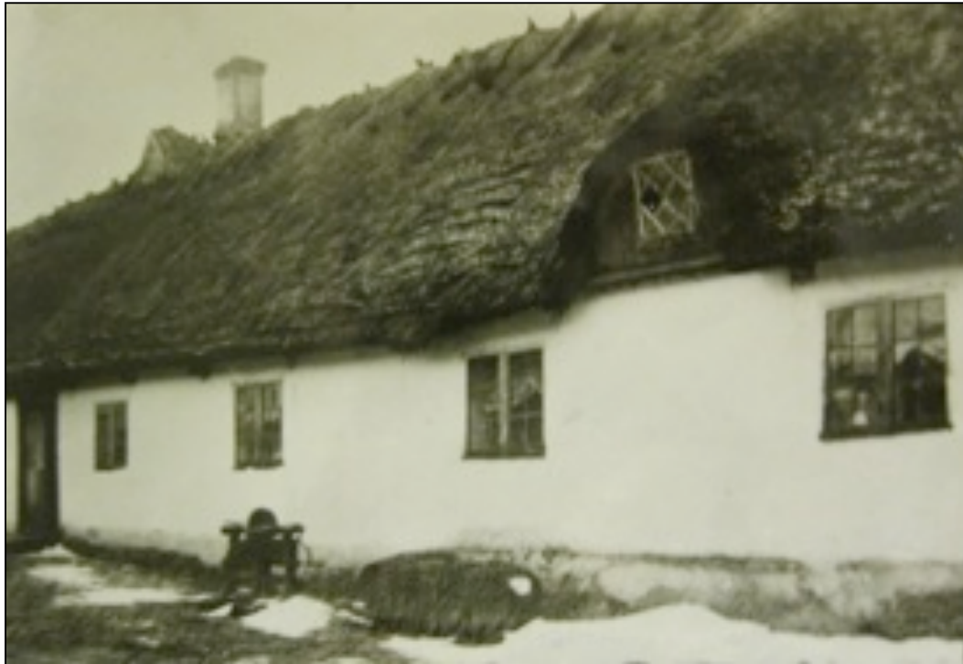
Bild 41. Svenstorp sn. Fönstrens glas är infästa med ett spröjsverk av bly. Det är svårt att utläsa om även homejans fönster är blyinfattad.
