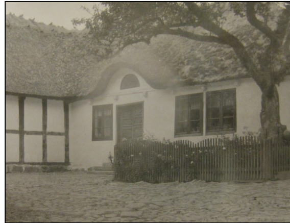
Bild 67. Ravlunda sn. Putsen på huset fortsätter upp på homejans front. Placeringen, fönstret och storleken på homejan betonar husets huvudingång.
