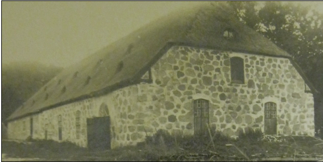
Bild 76. Ekeby sn. Ett fotografi från Folklivsarkivets insamlade dokument visar ett uthus som i denna studie har flest antal homejor på ett takfall. Homejorna är små men många och har här troligen också haft en vädrande funktion.
