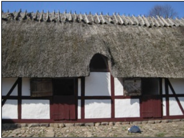
Bild 19. Gård från Lundager. Homejan ansluter till det övriga taket på läkt 10 av 14.
