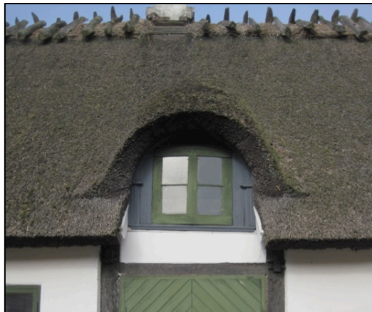
Bild 9. Hammenlöv sn. Axatorpet. Homeja nr 1. Observera den icke traditionella vinkeln på taksågget samt vingarna på homejans skägg.
