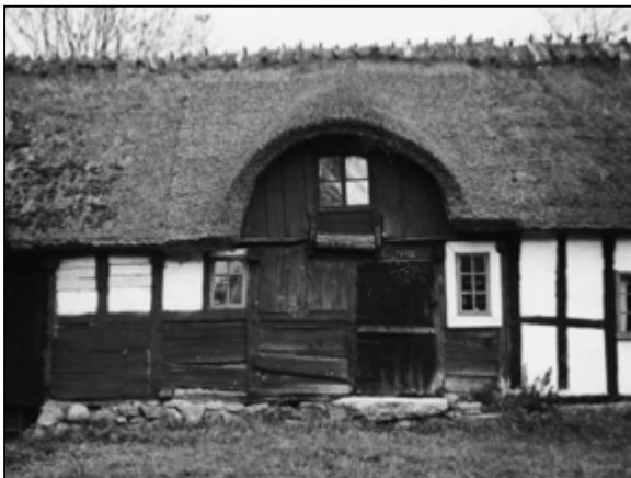
Bild 29. Blåherremölla. Fotot är tagit 1972 33 av Bo Swensson då homejan var nytäckt. De två mittersta uppståndare i ansluter på takläkt 15 av 18.
