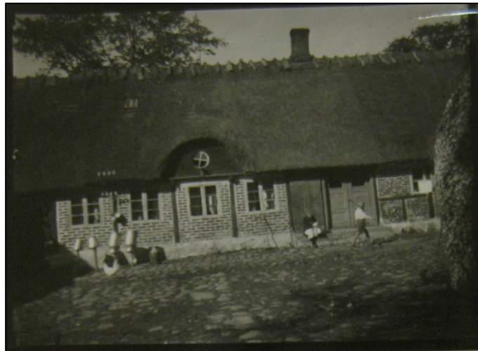
Bild 15. Tryde sn. Sälshög gamlegård. Notera att fönstret sitter snett på det gamla fotografiet samt ett takfönster till vänster om homejan som släpper in ljus på vinden.
