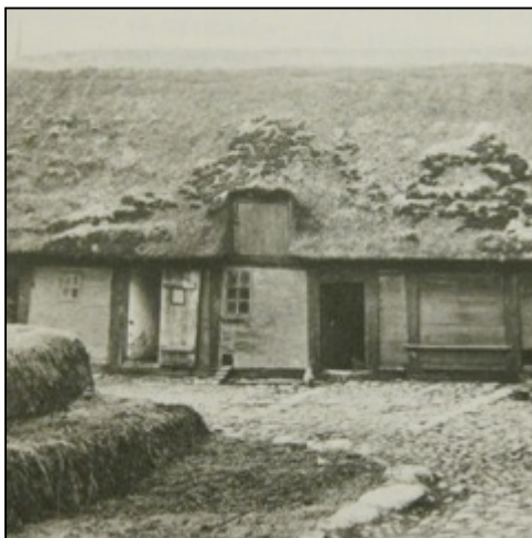
Bild 59 Vejstrup sn. Danmark. Takfallets längd tillåter en högre höjd på homejans öppning utan att lutningen blir för flack.
