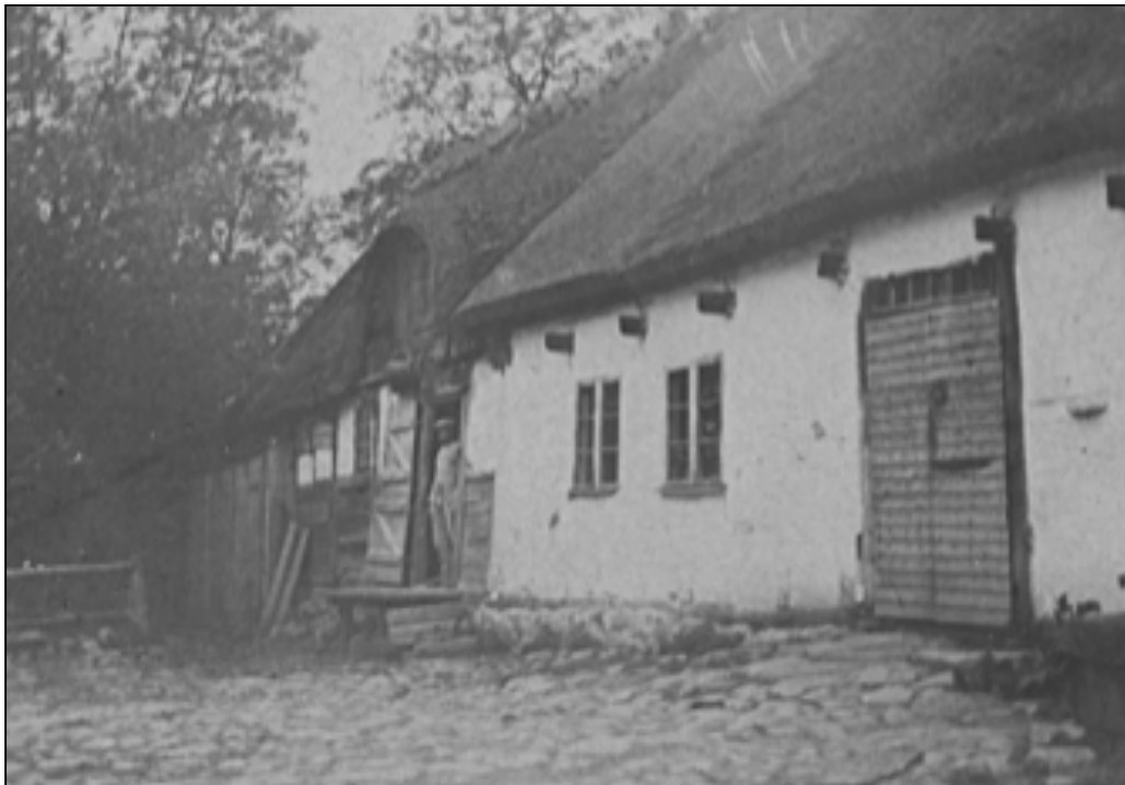
Bild 31. Blåherremölla 1911-1920. Lägga märke till hur även timret är vittat, till skillnad från bild 29 och bild 30.
