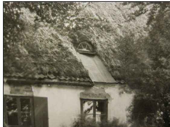
Bild 68. Örtofta sn. En plåt eller masonitskiva täcker för ytan nedanför homejan. Lägg märke till teglet i takskägget.
