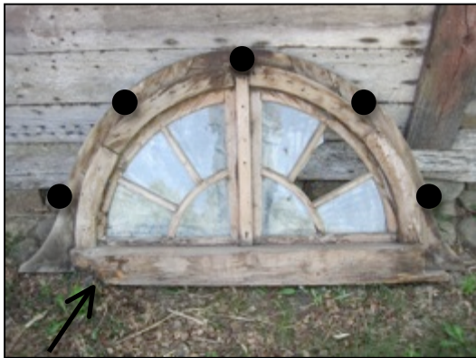
Bild 47. Nosaby sn. 2011. Insida. På vänstra delen kan man se att virke är borthugget troligen för att passa invid en sparre. De svarta cirkelarna visar var uppståndarna var placerade.
