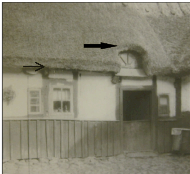
Bild 6. V. Sallerup sn. 1931. Nylagt halmtak och en homeja för ljusinsläpp.
