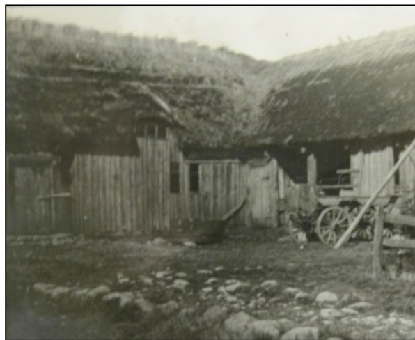
Bild 60. Venneberga sn. Öppningen ser inte ut att vara mer än 40 cm vilket gör att uppståndarna kan ansluta till taket tidigare utan att påverka lutningen negativt.
