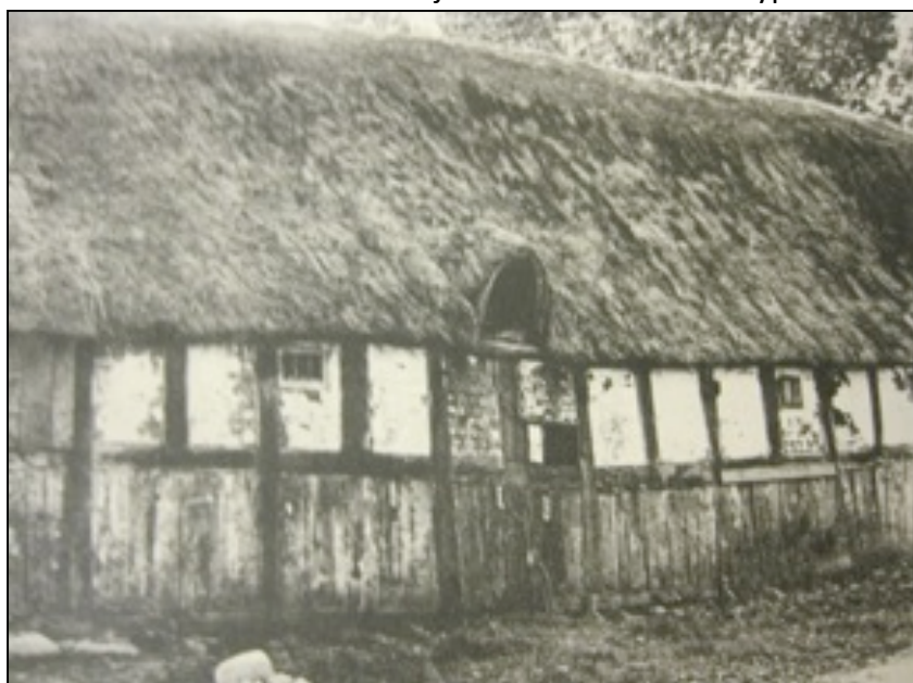
Bild 22. Clemmensen (1937:38) Gamlegård, Dover, Hjelmslev hd, Danmark 1910. På bilden ser man att homejans front lutar utåt. En möjlig orsak är att det skyddar väggen från regn men även att det skyddar det man tagit in från regn och blåst. Homejans skägg skyddar ytterligare mot regnet men bilden visar ett det är bortslitet.
