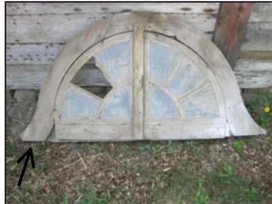
Bild 48. Nosaby sn. 2011. Utsida. Fasningen på sargens nederdel tyder på att det har suttit avrinningsbräder under homejan. Avrinningsbrädor är mycket vanligt på homejor som sitter en bit upp men förekommer även på homejor i skägget men då ofta med bara en bräda.
