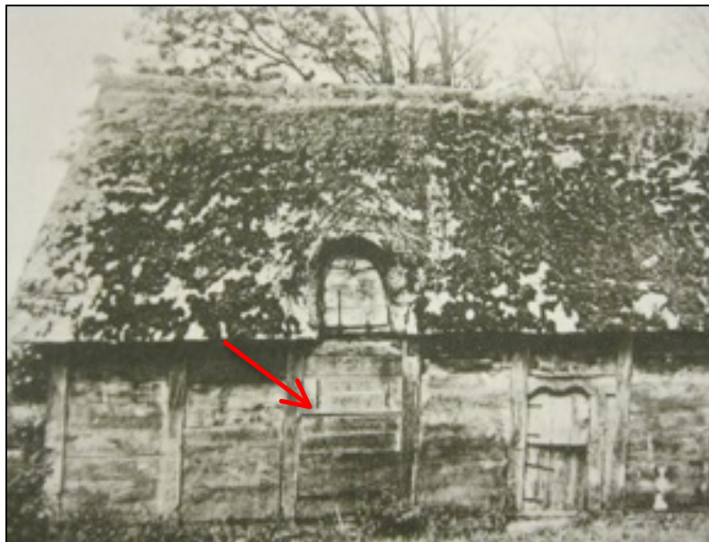
Bild 79. Tyrsterup sn., Danmark. Observera att luckan är fäst i lejden och öppnas utåt. I väggen under homejan finns ytterligare en lucka av två bräder. Den ena brädan sitter troligen fast i väggen och är förankrad i den andra med ett hängselbeslag. Se pil.
