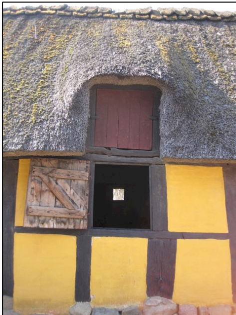
Bild 20. Husmandshus från Ødis Bramdrup ved Kolding. Det sitter en avtagbar dörr för öppningen i en fals som hålls på plats med två knadrikar. 4
