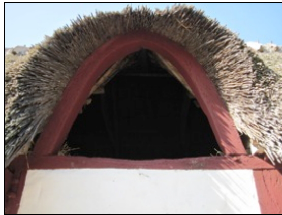
Bild 13. Lundager, Danmark. Observera slitningen på lejden. Tjockleken på frontens två timmer varierar, vilket kan tyda på att timret bara har fyrkantshuggits utan vidare dimensionering.
