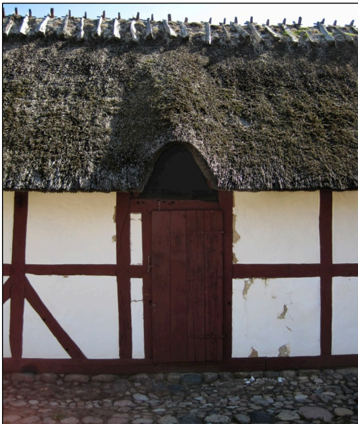
Bild 4. Gård från Lundager. Homeja nr 2. Överliggaren över dörren går kant i kant mot den andra stolpen på dörrens vänstra sida. Dörrstolpen på vänster sida om dörren är tappad i överliggaren och överliggaren är tappad i stolpen på dörrens högra sida.
