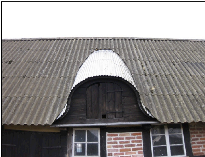
Bild 7. Tryde sn. Sälshög gamlegård. Homejan har en tydlig klockformad front.
