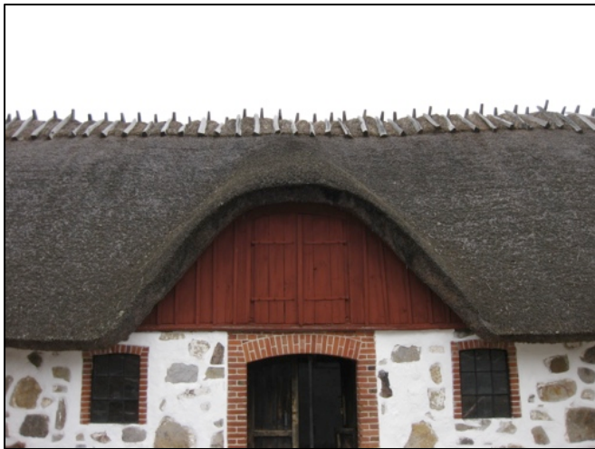
Bild 5. Andrarum sn. Magasinet. Detta är den bredaste homejan som påträffats i fältarbetet.
