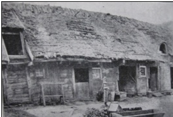
Bild 63. Knislinge sn. Austringagården. Observera avsaknaden av lucka/ luckor. Takkonstruktionen kan variera men rimligen är det två uppståndare med homejeläkt emellan som stråttaket är bundet i.
