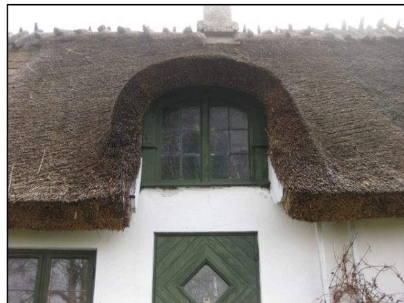
Bild 10. Hammenlöv sn. Axatorpet. Homeja nr 2. Taksågget är uppslaget på det traditionellt skånska viset, ca 90° mot taket.
