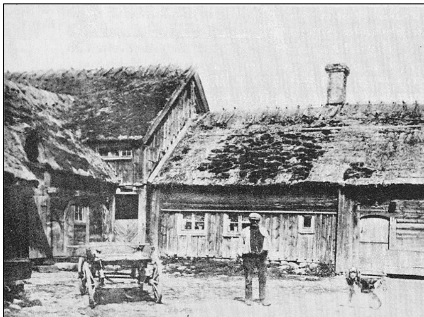
Bild 2. Knislinge sn. Austringagården, Troligen äldsta fotografiet på gården. Observera lutningen på homejan och slitningen på homejeskägget.
