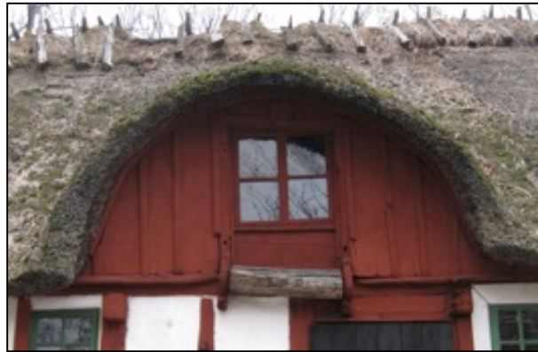
Bild 23. Blåherremölla. Maglehem sn. Homejan är placerad på kvarndelen av byggnaden och har använts för att ta in säckar med säd för malning 30 .
