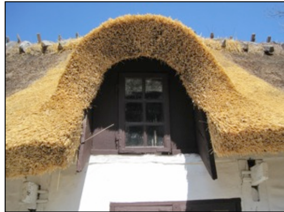
Bild 32. Homeja nytäckt med halm. Brädorna på sidan fungerar som vindskivor och håller de yttersta stråna på plats.
