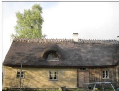
Bild 51. Färlöv sn. Rekonstruerad homeja utifrån fotografi och spår i takkonstruktionen. Norup 2011.
