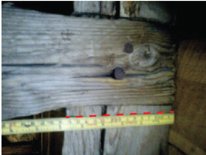
Figur 16 Möte mellan stödben och högben
