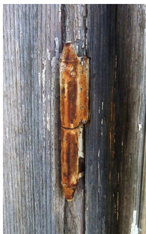
Figur 37. Utvändigt gångjärn.
