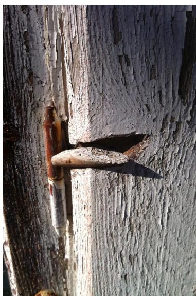
Figur 22. Kvisturfall.
