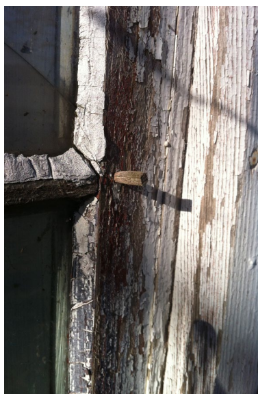
Figur 21. Trätappar/trä-plugg/pinne som "kryper".
