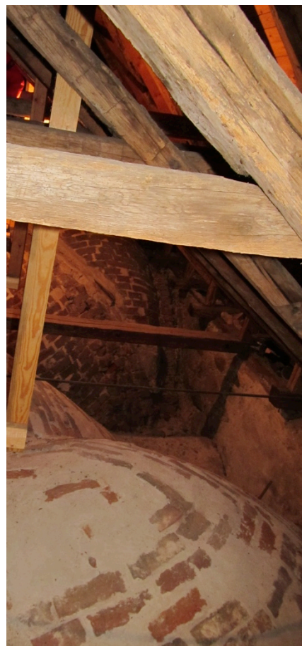
Figur 8. De murade valvens ovansida på Barsebäcks kyrkvind. Kajsa Nyström Rudling.
