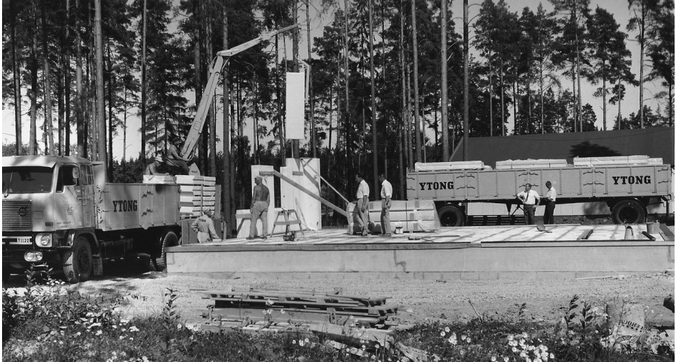
Fotografi 3. Montering av ett enfamiljshus med Ytongelement år 1967. Foto: Yxhultbygdens Kultur- och Hembygdsförening, bildarkiv nr. 7060. Fotograf okänd.
