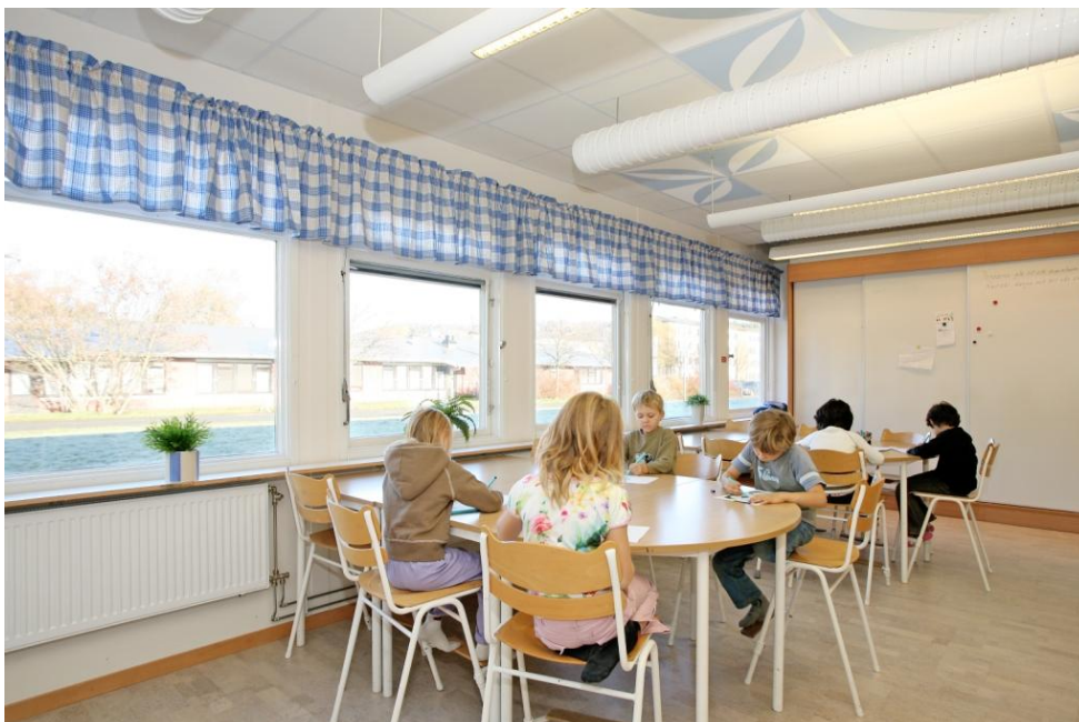
Klassrum efter åtgärder: Nu fick klassrummen separat ventilation med god luftutbyteseffektivitet och vattenburna radiatorer.
