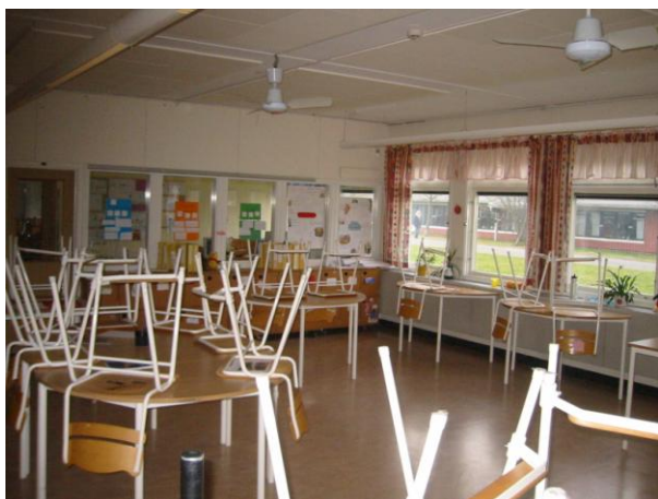
Klassrum 1 före åtgärder
