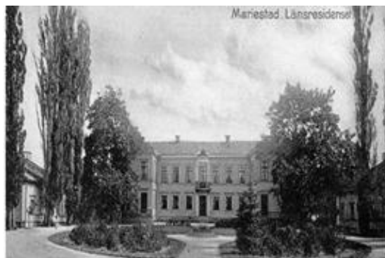
Figur 6. Bilden är tagen år 1900 och visar på gårdsplanens utformning av de symmetriska njurarformade rabatterna i söder. Bilden är tagen från Mariestads bildarkiv. Fotograf: Ludvig Ericsson.
