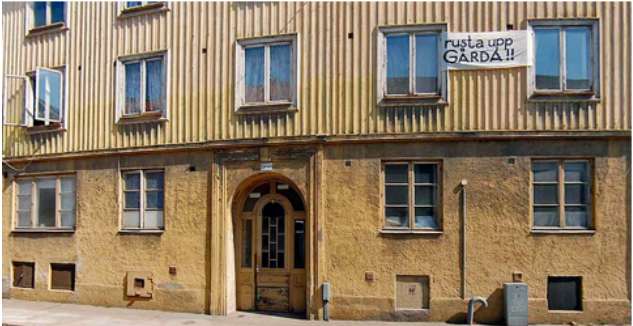
Figur 6, visar fasaden av de rivningshotade kvarteren. (byggnadsvardsnytt.files.wordpress.com)
