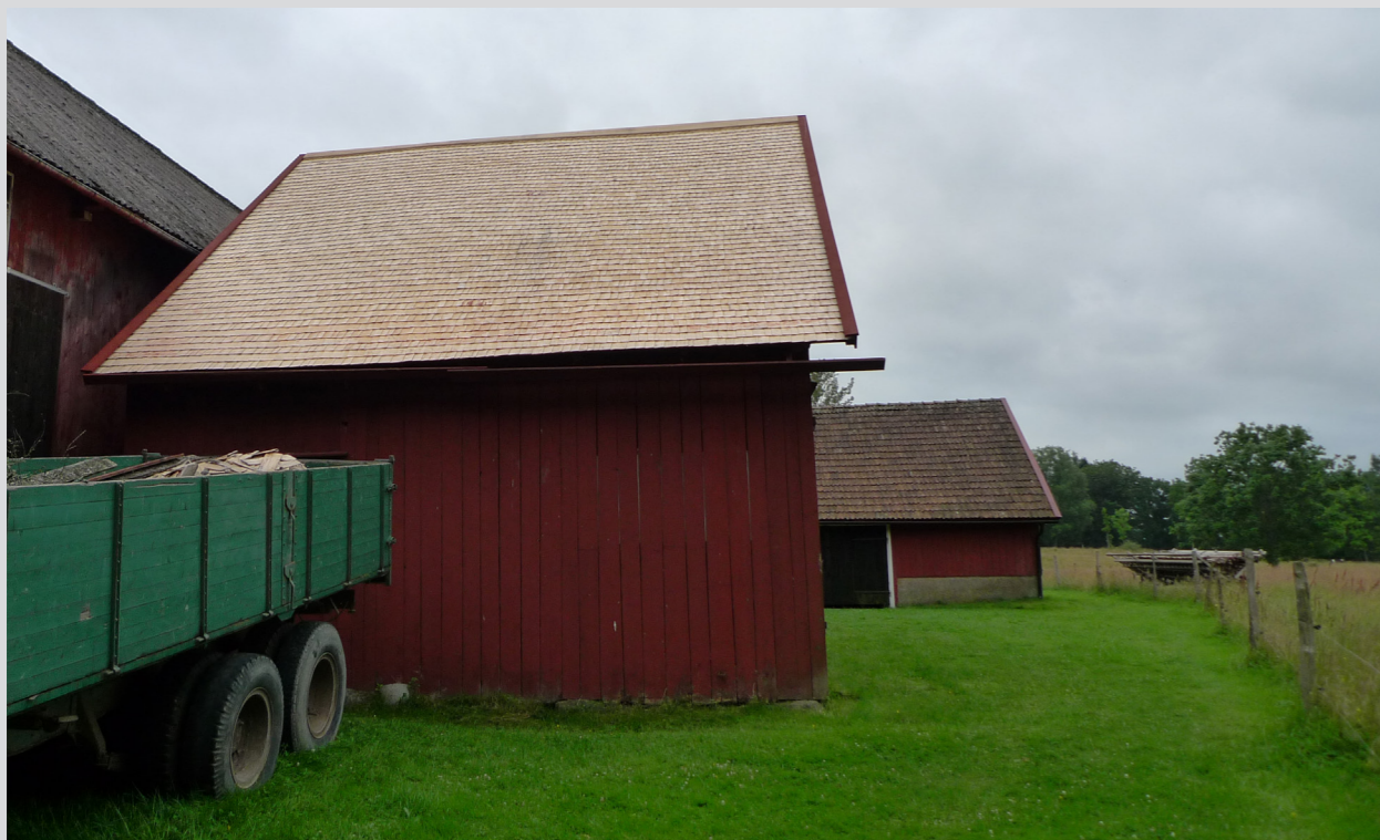
Figur 3.26. Det färdiga taket av stickspån.
