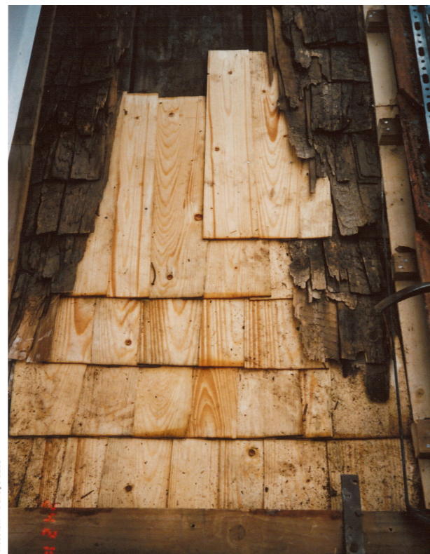
Figur 7.1 och 7.2. Det här spåntaket hade skadats av stora mängder vatten som runnit från en takkupa till vänster. Skadat spån skars bort och ersattes av nya. Bilden till höger visar taket under pågående lagning. Fler nya skift lades innan läkt och tegelpannor kunde läggas tillbaka.
