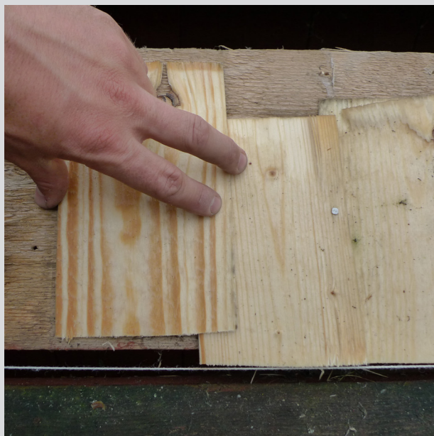
Figur 3.22. Första lagret i fotskiftet lades med 1/3 långa spån. Lägg märke till det vita riktsnöret.
