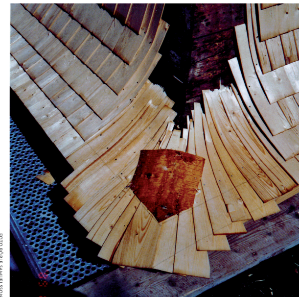
Figur 3.15. Sista lagret i takfotskiftet med andra skiftets inskott. Spånen nederkant kapades efter att alla spån spikats fast.
