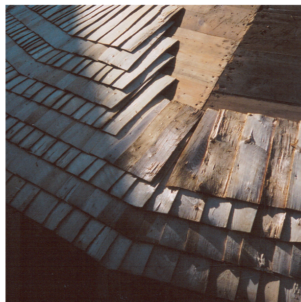
Figur 3.13. Här är vinkeln mellan takfallen relativt liten. Men det är ändå viktigt att spånen även i nederkant ligger omlott med minst 1 tum för att inte vatten ska leta sig in mellan spånen.
