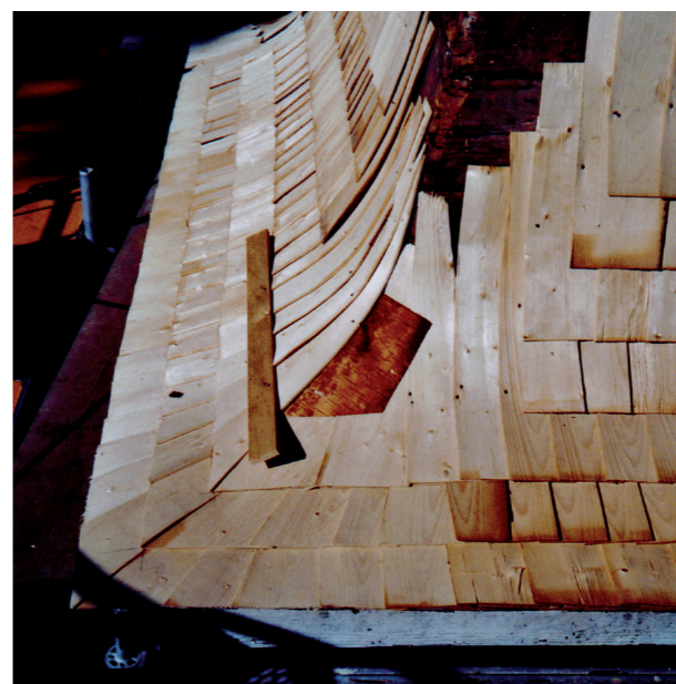
Figur 3.16. Alla skift över hörnet kompletterades med inskott.
