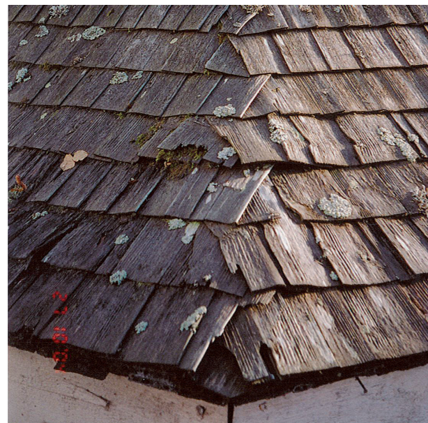
Figur 3.12. Här täcks snednocken genom att spånskiften fortsätter över nocken. Spån på de båda takfallen ligger omlott.
