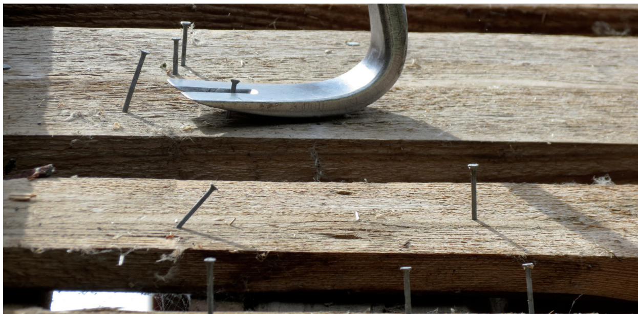
Figur 3.7. Spånen är bortrivna men kvar är den hårt sittande galvaniserade spiken som en och en dras ut med kofot.
