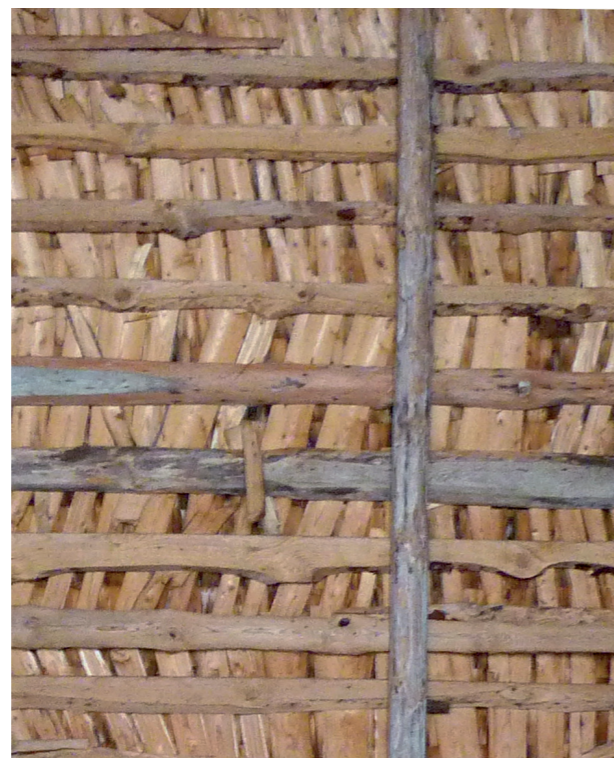
Figur 3.2. Underlagstak där sekundaspån lagts snett för att bära upp den egentliga spåntäckningen.
