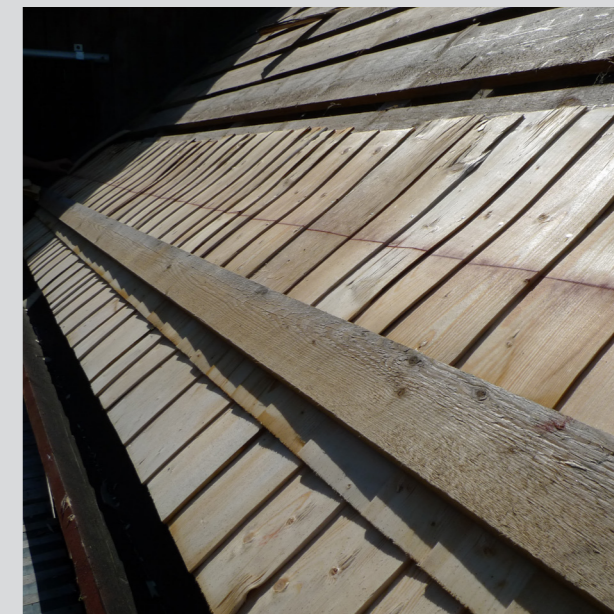
Figur 3.25. Takets tredje skift lades med stöd av riktbrädan. Det fjärde skiftet är på väg att läggas mot den röda snörlåmarkeringen.
