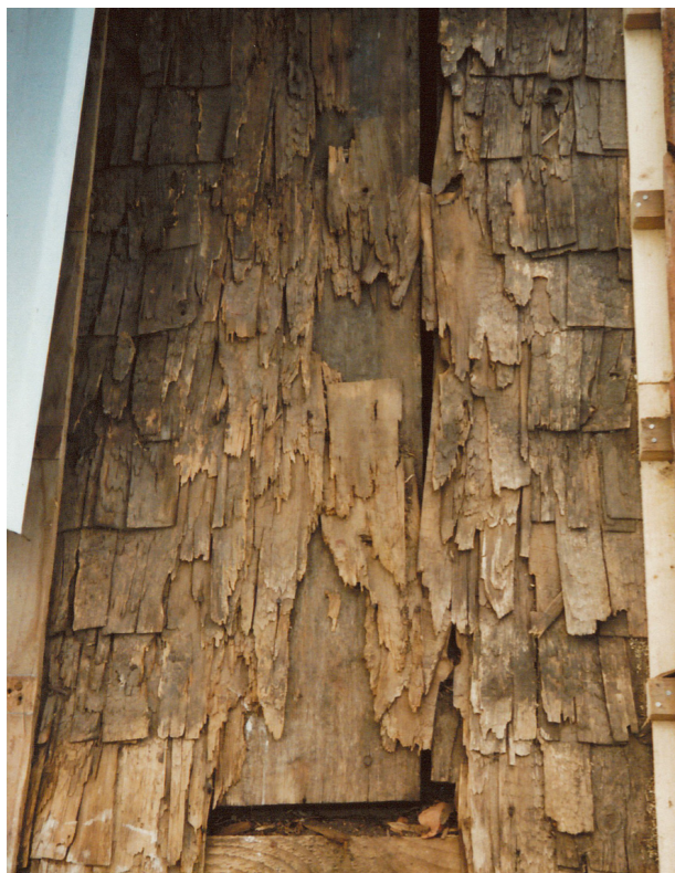
Figur 7.1 och 7.2. Det här spåntaket hade skadats av stora mängder vatten som runnit från en takkupa till vänster. Skadat spån skars bort och ersattes av nya. Bilden till höger visar taket under pågående lagning. Fler nya skift lades innan läkt och tegelpannor kunde läggas tillbaka.
