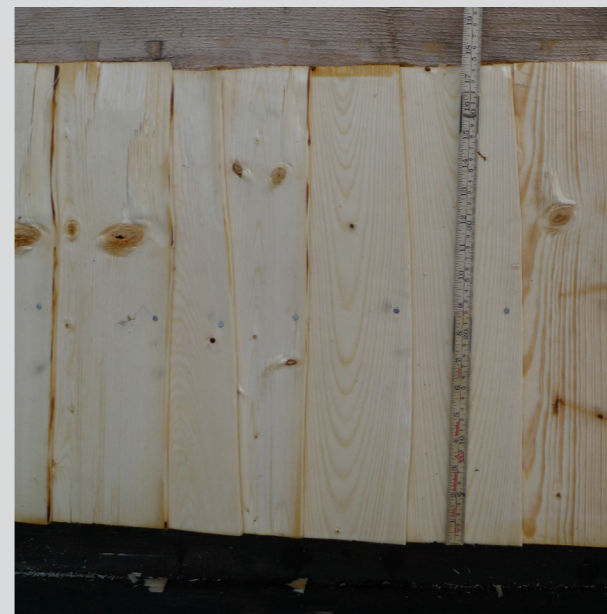
Figur 3.24. Spiken placerades i överlappet ungefär mitt på spånen.
