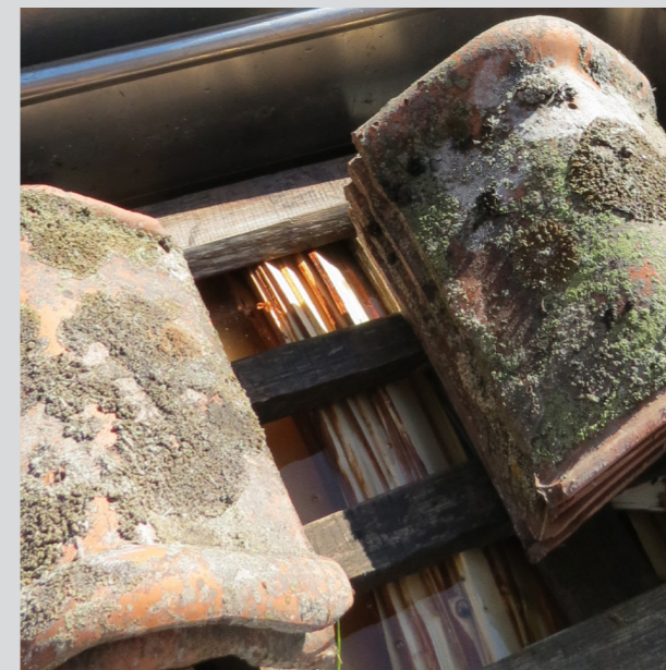
Figur 3.20. Spånen lades i blöt i minst en halv dag.
