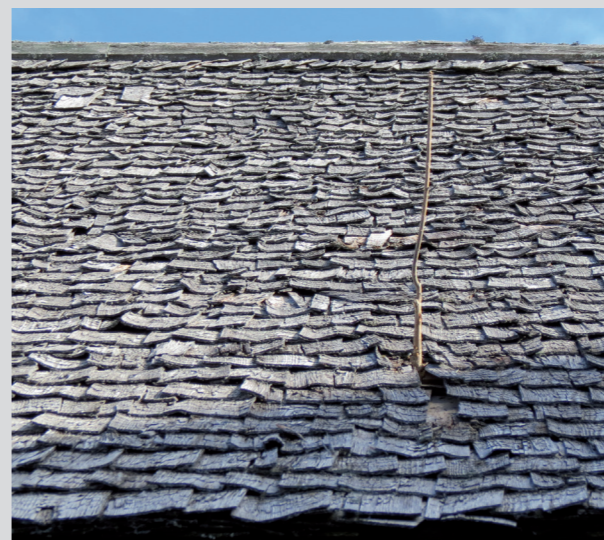
Figur 3.18. Taket var inte tätt, på flera ställen kunde man både se och sticka en käpp igenom det.
