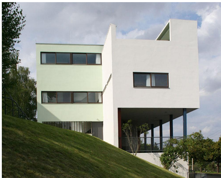
Fig. 1. Le Corbusier, Villa i Weissenhof, Stuttgart, Tyskland, 1927
