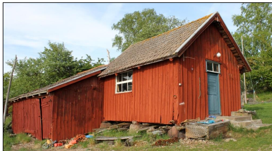
Fig68: Runnö, Norrgården, gammal sjöbod, med skiftesverk under locklistpanelen.
