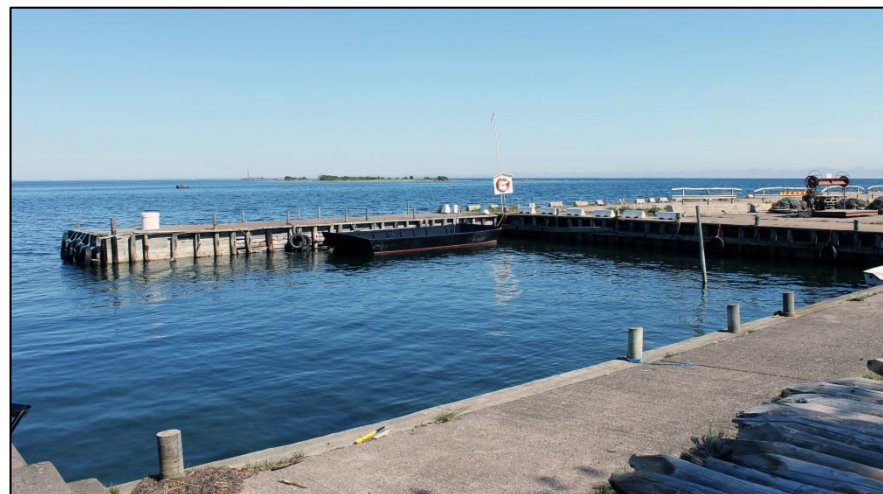
Fig58: Lurkan i Bergkvara hamn, garnpråm i vattnet, i förgrunden pålar till ålbottengarnen.
