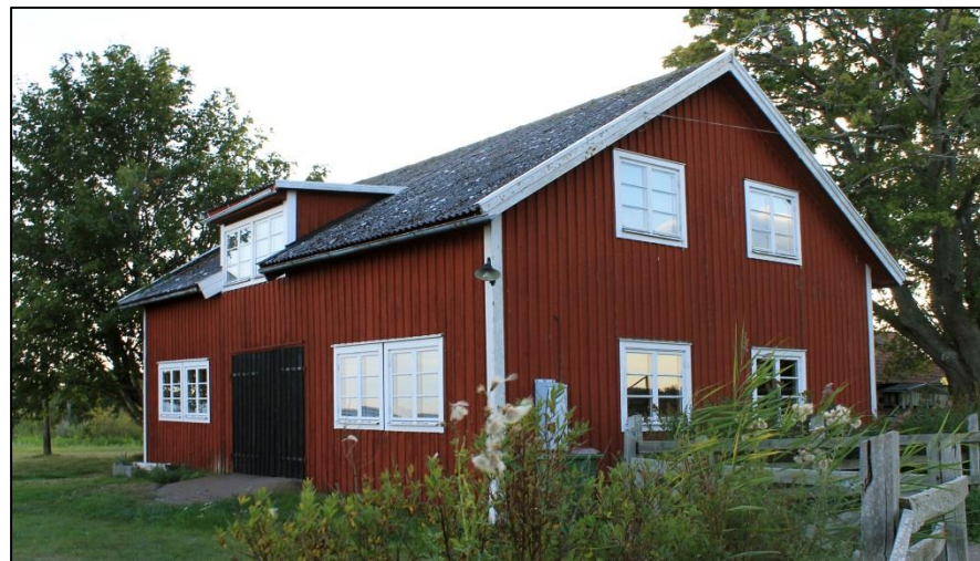
Fig39: Stor ålbottengarnbod, Bottorp, med en för byggnadstypen ovanlig takkupa.
