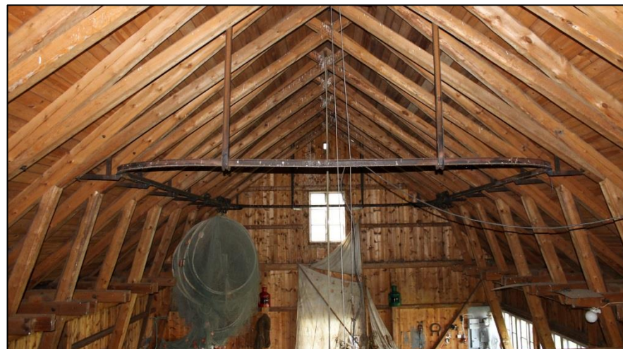
Fig33: Gotisk takstol i garnladan. Råls för upphängning av ålbottengarn.
