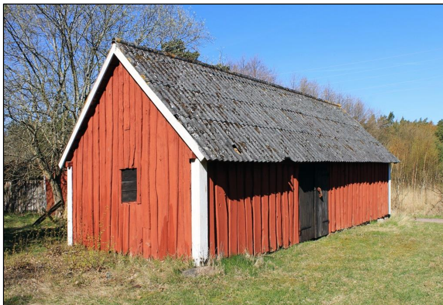
Fig49: Äldre sjöbod från 1800-talets senare hälft med stockbakpanel/lockpanel med vankant. Renoverat tak med asbest cementplattor i mitten av 1900-talet.
