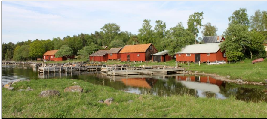
Fig65: Runnö Norrgården, ålbottengarnbodars samlade vid hamnen bestående av bryggor på stenkistor.
