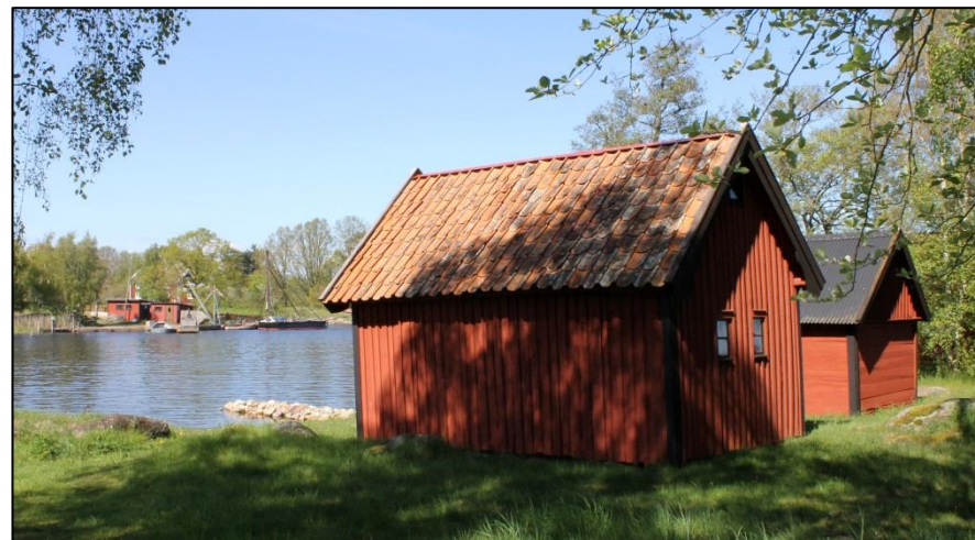
Fig61: Äldre sjöbodar vid Djursvik, en kås i sten ses framför boden,
