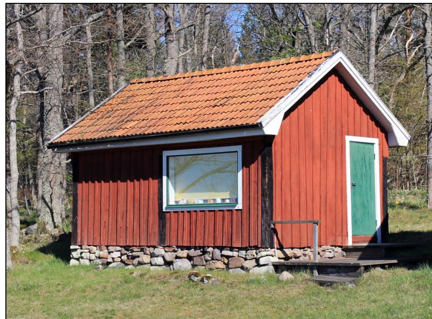
Fig45: Panelklädd sjöbod av skiftesverk, från 1800-talets andrahälft. Ombyggd till bostad.
