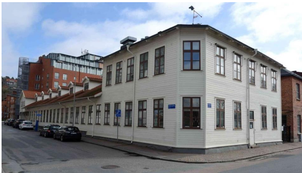
FIGUR 3,4 & 5. På de tre bilderna ovan syns överst till vänster hästskosömfabriken med skyddsområdet markerat. Till höger syns en aktuell kartbild där tillbyggnaden inom skyddsområdet är markerat. Längst ner syns hästskosömfabriken sedd från Ågatan.
