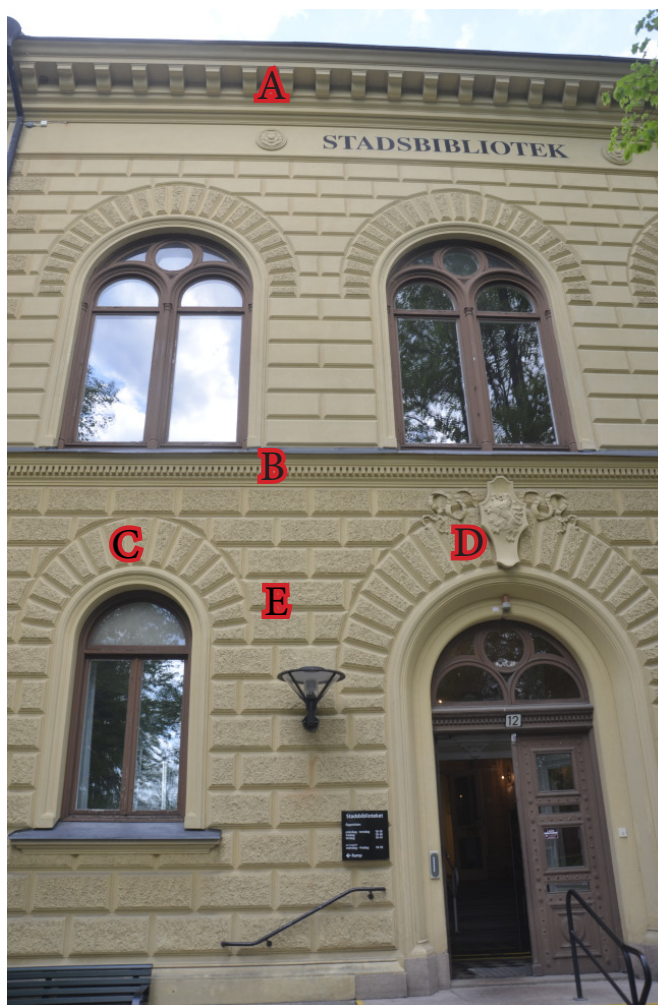
Figur 1 Mariestads stadsbibliotek, krongesims (A), gördelgesims (B), fönster (C)- och dörrömfattningar (D) samt kvaderstensputs (E).
