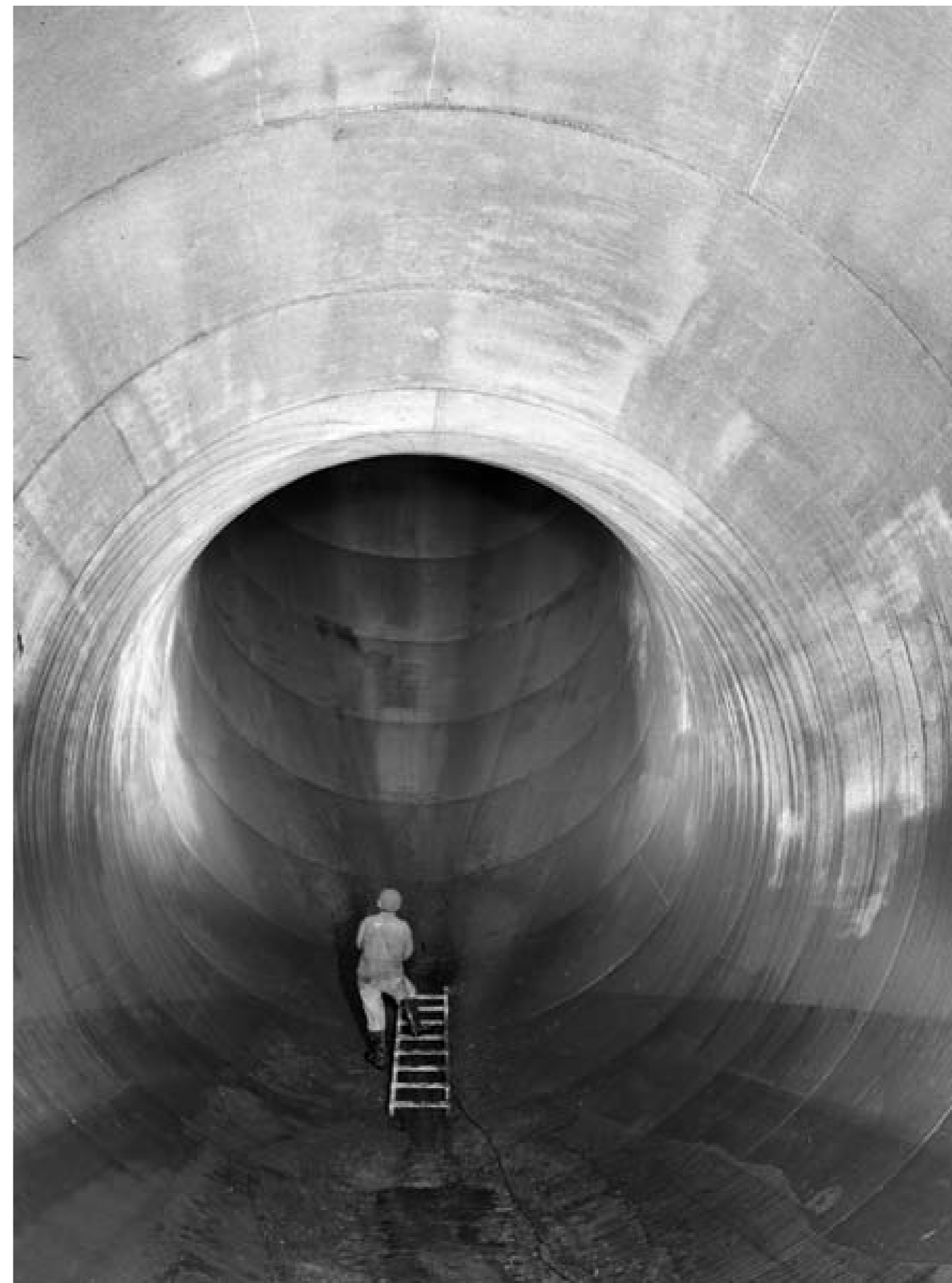
Tilloppstub till turbinsnäckan i de 85 meter djupa tilloppsschakten som ska driva turbinerna på vardera 90 000 hästkrafter, Hjalta, 1950. Inflow tube to the turbine shell in the 85 m deep inflow shaft that will drive each turbine at 90,000 horsepower, Hjalta, 1950.
