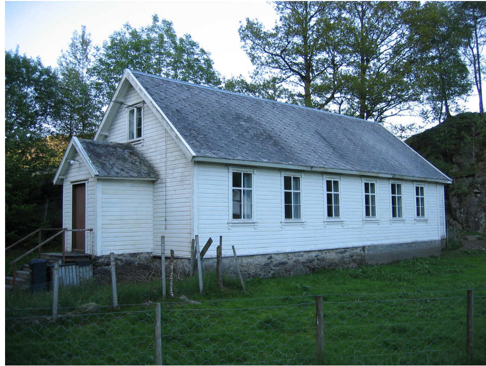
Figur 3. Emmaus, Refsbygd bedehus i Suldal kommune. Bedehuset ble bygget i 1925 etter tegninger av Thomas Fjetland. Forlenget i 1957, dvs. de tre vinduene til høyre. Foto: L. Mydland 2011.
