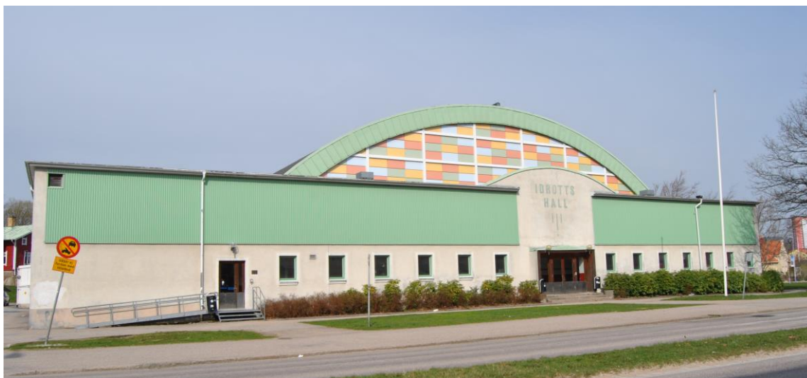
Fig. 9. Uddevallas idrottshalls framsida. Foto Charlotta Claesson
