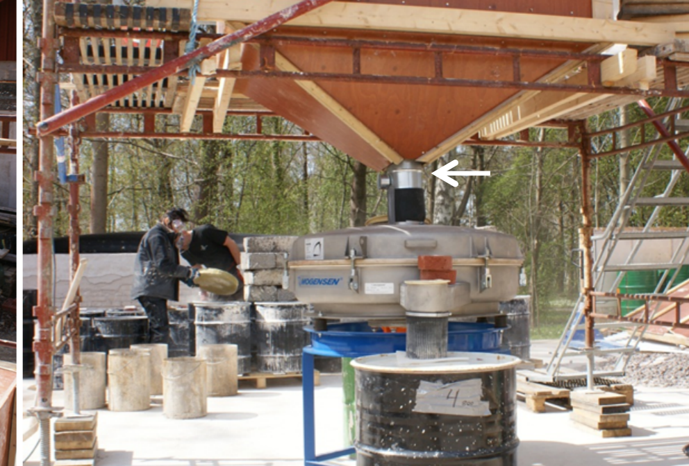
Fig. 50. Tömningslåda och sikt. Siktmaskinen är så konstruerad så att det material som är för grovt sorteras bort som skräp och fördelas till ett separat fat (ej synligt i bild, placerat bakom sikten). Endast det material som är tillräckligt fint passerar sikten och fördelas till det fat som det sedan förvaras i (det svarta fatet i bildens förgrund). Siktdukens masköppning är 1 mm. Tömningslåda och sikt är sammankopplade med ett reglerbart spjäll (vit pil). Med spjället regleras så att mängden kalk som tillförs sikten inte blir för stor på en gång. I fråga om förbättringar så är det tömningslådan och dess moment samt frammatningen av kalk som är de delar av tillverkningen som är i behov av utveckling. I bakgrunden Kristina Bergkvist och Tomas Sandberg.
