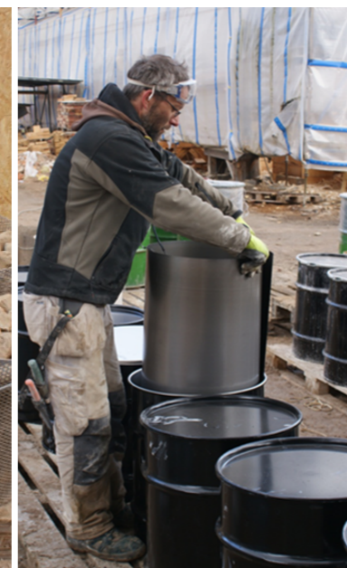
Fig. 60, 61. I det förberedande arbetet sätts plåtsvep i alla de uppställda faten (fig. 60). Svepen är öppna och valsade till en större radie än fatet. Effekten blir att svepet spänner mot fatets insida (se röd pil i figur 61). Om svepet inte spänner mot uppstår ett mellanrum mellan fatets insida och svepet. Under släckningen fylls mellanrummet med kalk och försvårar tömningen. Svepen är tillverkade i 0,7 mm svartplåt. Höjden är 500 mm och svepets plåtkanter överlappar varandra med ca 50 mm.
