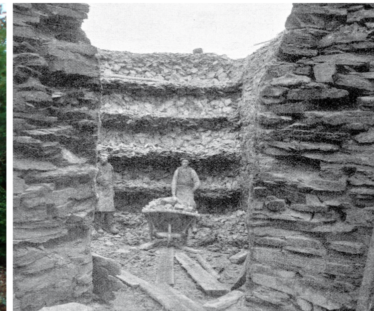
Fig. 21. Västergötland, Kinnekulle, Hönsäters kalkbrott 1901. Kalkugnen sedd från ingången under tömning. Ugnens sidoväggar består av kallmurade alunskifferblock och är synliga i förgrunden. I bakgrunden framträder de omväxlande lagren av kalksten och alunskiffer (Holm 1901). Fotograf G. Holm och O. Kjellström.
