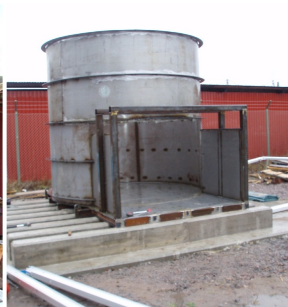
Fig. 28. I bild syns ugnens kabinettt/yttre form som sedan infodras med eldfast material (se bilaga 1). Kabinettet är placerat på gjutna balkar. Mellan balkarna finns ett luftat utrymme för att undersidan av ugnen skall ventileras och kylas.
