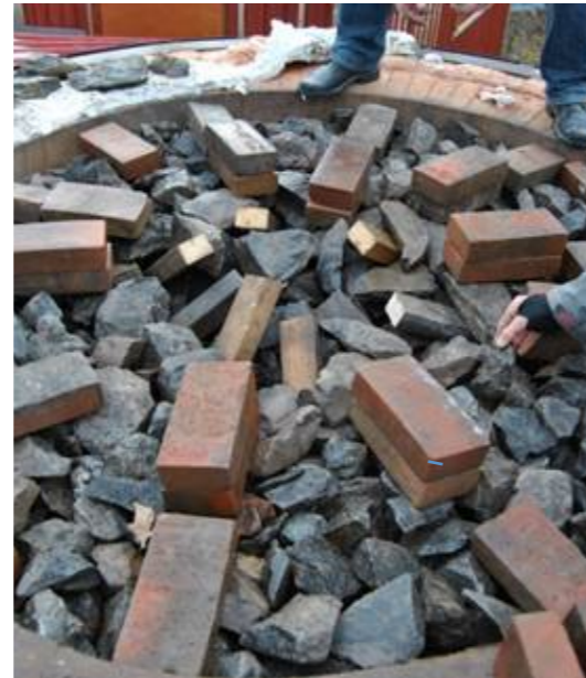
Fig. 37. Tegelstenarna placeras med distans till varandra. Mot centrum placeras två tegelstenar på höjden och en direkt på kalkstenen mot ugnsväggen.
