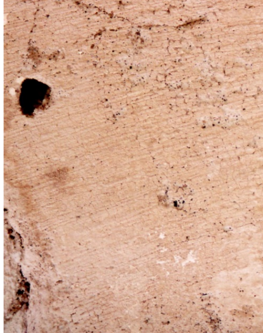
Fig. 5. Gillstad kyrka, södra långhusväggen. I bild syns ytan av underligande 1600-tals puts. På ytan framträder tydliga spår av att det yttre skiktet bruk har borstats ut. Skiktet är mycket tunt, ca 1 mm. Bruket som använts är mycket finkornigt och bindemedelsrikt. Det underligande skiktet är tjockt, ca 15 mm, bindemedelsrikt och består av grov ballast.
