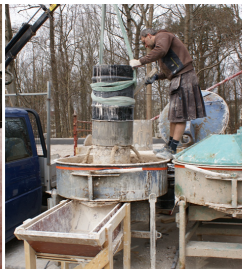
Fig. 74. Fatet hänger med locket ner. Lockringen och locket tas av från fatet varpå svepet och innehållet glider ut ur fatet. Utan svepet skulle det vara tvunget att gräva ut kalken, ett förfarande som är betydligt mer tidskrävande och arbetsamt. Blandarna är försedda med avtagbara huvar och startas från marknivå. I bild Tomas Sandberg.
