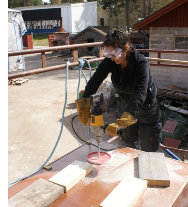
Fig. 49. Genom hålen i behållarens lock sticks en visp kopplad till en bormaskin ner. Under vispningen slungas kalken ur korgen och faller ner i den trattformade botten av lådan. Varje korg tar ca 1-2 minuter att tömma. På vispens axel finns ett löst monterat lock som förhindrar att kalken dammar ut ur lådans hål under vispningen. I bild Kristina Bergkvist.
