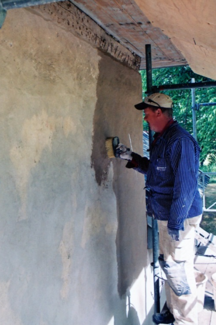
Fig. 4. Gillstad kyrka, östra gaveln. I bild Bengt Johansson i färd med att borsta in ett mycket tunt lager av puts på kyrkans fasad. Tjockleken uppgår till ca 0,5-1 mm. Arbetsmetoden efterliknar de fynd av verktygsspår som återfinns på ytan av de äldre putslagren (se fig. 5).
