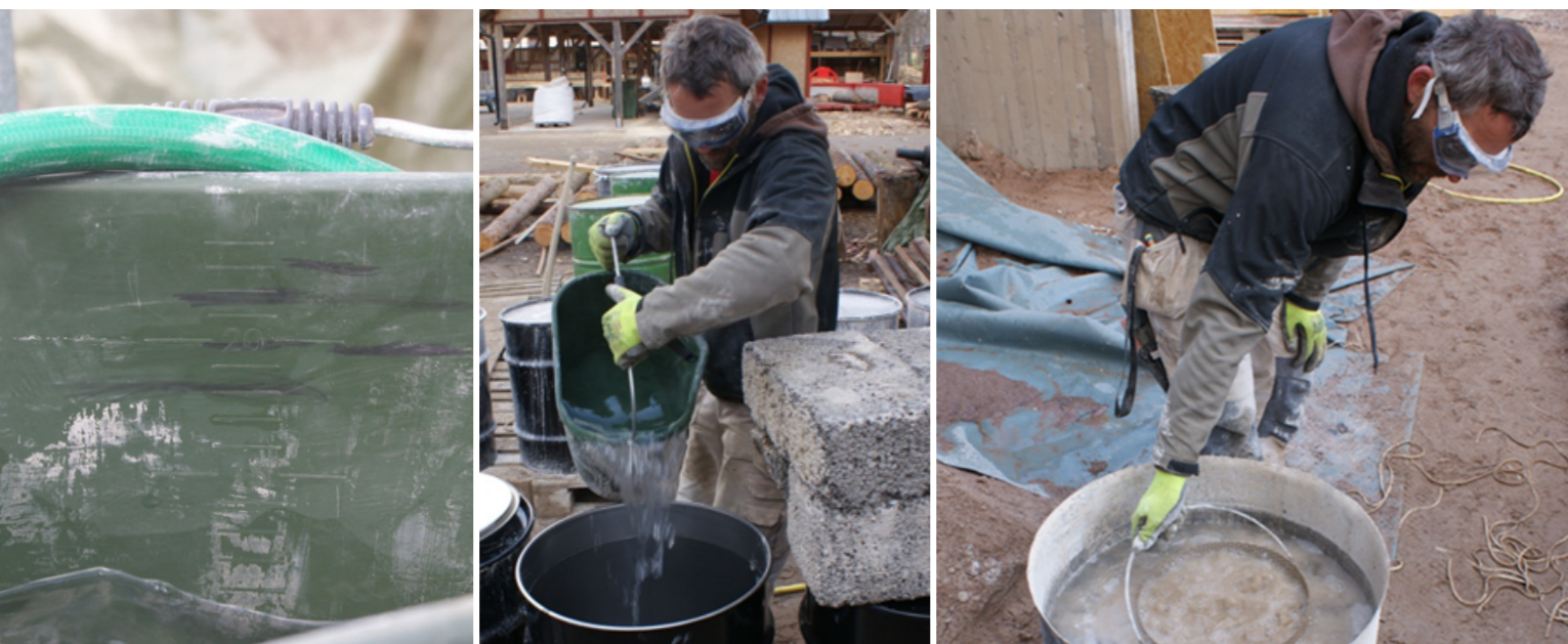
Fig. 62, 63. Vattnet pumpas fram och mäts upp i en graderad hink (fig. 62). Vattnet håller en temperatur av ca 80 °C. . Vattnet hålls ner i släckningsfatet (fig. 63).
