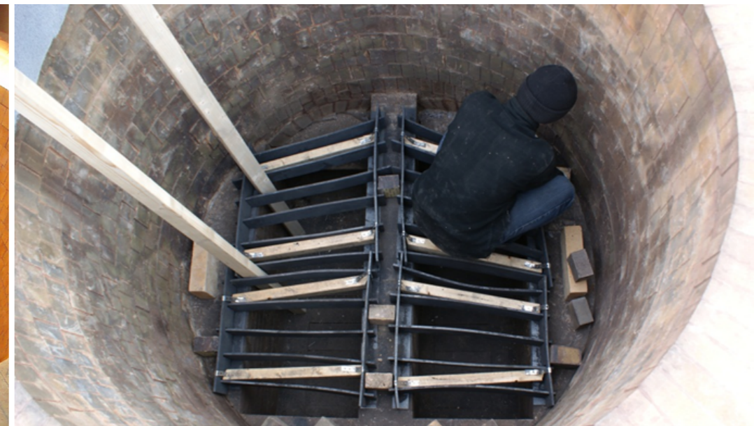
Fig. 30, 31. I ugnens botten syns murverket som rostrett kommer att placeras på samt det utrymme där värmen från förugnen leds in under rostrett. I fig. 31 är rostrett placerat på murverket.
