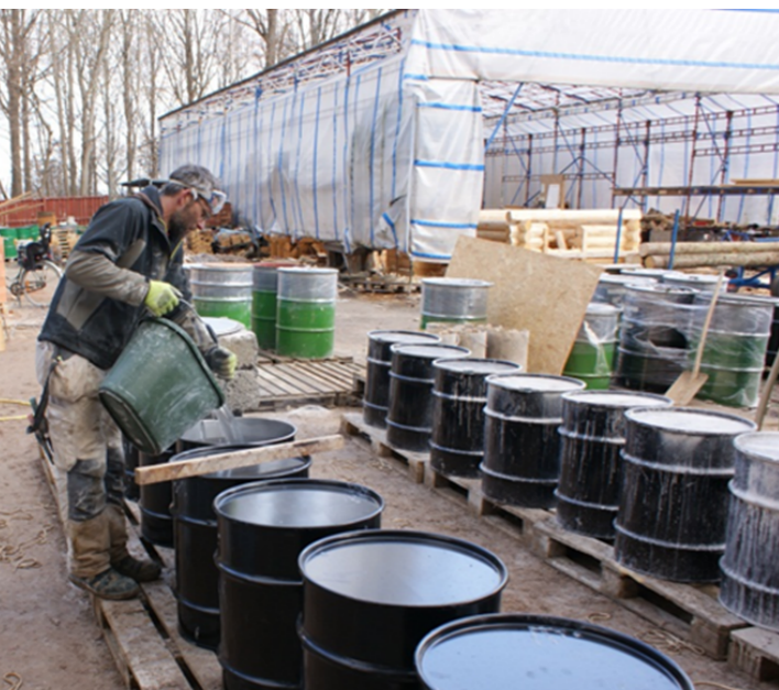
Fig. 57. Byggården Mariestad. Uppställningen av släckningsfaten i rader gör att släckningen kan utföras mer rationellt, t.ex. kan ett fat fyllas med varmt vatten och kalksten under tiden som släckningsprocessen pågår i ett annat fat i motsatt rad.
