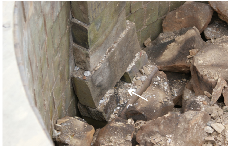
Fig. 34. I samband med packningen byggs de konstruktioner som tempgivarna är placerade i. Konstruktionen benämns "hus" och bildar ett litet utrymme var temperatursonderna är placerad. Temperatursonden registrerar på det viset den temperaturen som huset värms till. I den del av huset som är vänd in emot ugnen och den ilastade kalkstenen finns en liten öppning (se vit pil). Framför öppningen placeras en kalksten så att den täcker hålet. Syftet är att den temperatur som kalkstenen är uppvärmd till ska tillsammans med temperaturen på husets väggar utgöra mätvärdet. Genom konstruktionen minskar risken att mätsonden värms lokalt genom sticklågor och heta gaser som mellan stenarna har en högre temperatur än vad stenen är uppvärmd till.
