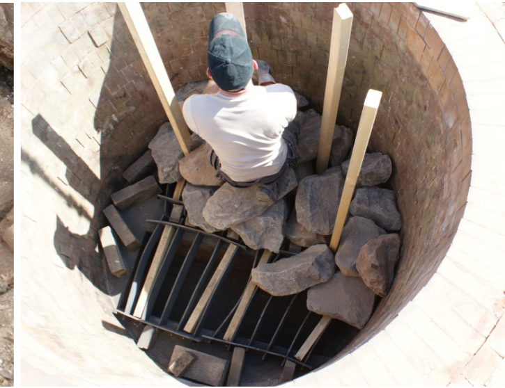
Fig. 35. I bild har packningen av ugnen påbörjats av Mark Dowling. I samband med att de stora stenarna i botten placeras ut sätts dragstockarna på plats. I ugnen placeras åtta stycken dragstockar jämnt fördelade i en cirkel med ett avstånd av ca 400 mm från varandra och ugnsväggen. De stora stenarna i botten ställs något glest och om möjligt på högkant för att inte skapa ett lock som förbränningsgaserna har svårt att passera. Övergripande gäller denna regel även för de något mindre fraktionerna medan det för den minsta fraktionen på toppen har mindre betydelse.
