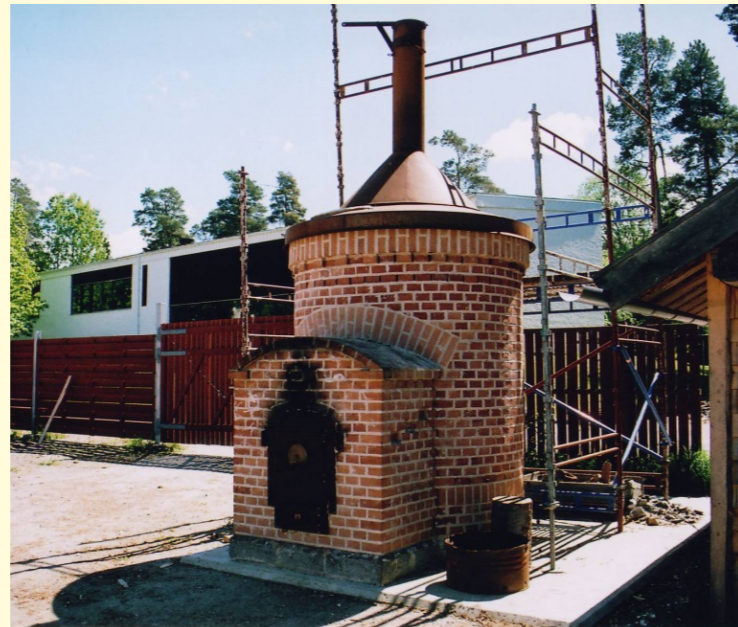
Fig. 22, 23, 24. Mariestad, bygggården. Ugnen är placerad på en gjuten betongplatta, är rund och har en förugn med luckor i stål. Ugnen har ett löstagbart, isolerat tak av stål. Ugnen lastas och töms ovanifrån (fig. 22). Ugnsväggen består ytterst av fasadtegel, tre olika typer av isolering samt eldfast tegel (fig. 23, 24). Kalkstenen vilar i botten av ugnen på ett rooster av gjutjärn (I, fig. 23). Förugnen har en förträngning mellan förugnen och ugnsutrymmet som kalken är placerad i som gör att eldningskanalen smalnar av (II, fig. 23). Innanför luckorna placeras veden (III, fig. 23). Skissteking utförd av Anders Göransson.
