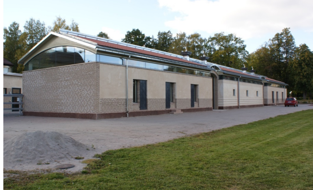
Fig. 7. Mariestad, Murhusets västra fasad och södra gavel. Den västra fasaden är indelad i tre sektioner. Den mellersta sektionen har brädriven yta medan de två yttre har stockad eller så kallad käppad yta, vilket innebär att ytan har en rå textur. Med erfarenheterna av kalkens tillstyvnande och hur sandens kornfördelning och max kornstorlek inverkar på arbetbarheten valdes i projektet en väl graderad sand med korn max 3 mm. Sandens kornfördelning är framtagen av Jonny Eriksson och blandad av Brogårds sand AB. I relation till den grövsta sanden som användes vid omputsningen av Gillstad kyrka och Källstorps gårdskapell som hade ett korn på max 4 mm så har sanden en betydligt mindre mängd sand över 2 mm. Blandningsförhållandet är ca 1 del kalk på 2,4 delar sand. Andra skillnader är att kalken inte är upparbetad efter släckningen (se kapitel 5.6). Erfarenheterna från projektet visar på en mindre benägenhet till sprickbildning samt bättre arbetbarhet när kalken inte är upparbetad.
