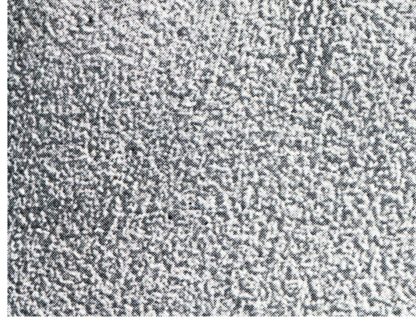
Fig. 9 b. Rivputs. Ytan är efter att den torkat riven med en rivbräda bestående av en platta med handtag på. Plattan är genomborrad av tätt sittande spik. När rivningen utförs trycks plattan med spiken mot putsen och förs över ytan i cirkelformade rörelser. Under arbetet rivs ca 3 mm av putsens yta bort.
