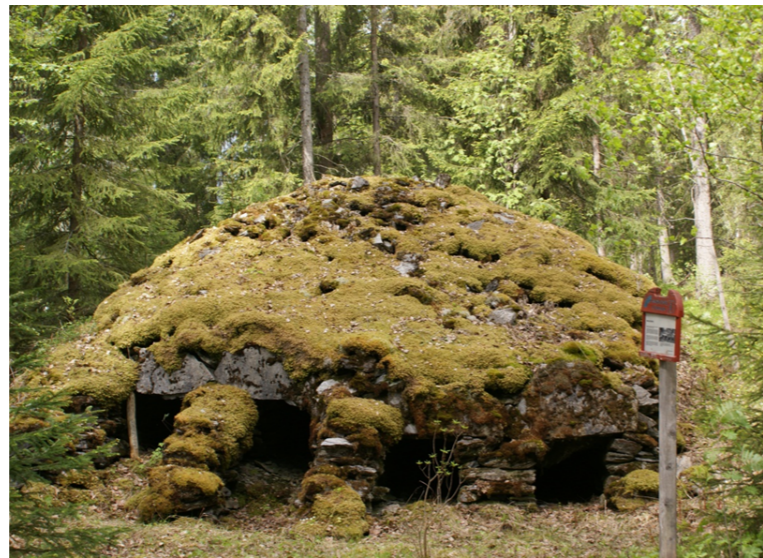
Fig. 33. Ås, Krokoms kommun, Jämtland. Bilden visar en fyripipig kalkugn. Ugnen uppfördes under 1800-talets slut men tändes aldrig och är i dag en fornlämning. I förgrunden i marknivå syns fyra öppningar. Under bränningen eldades det i alla de fyra öppningarna samtidigt. Ugnskonstruktionen ger en stor värmeavgivningsyta i förhållande till ugnens höjd.
