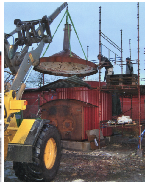
Fig. 29. Ugnen lastas och lossas genom att huvan är möjlig att lyfta av. Huvans insida är försedd med eldfast isolering. I bild Tomas Sandberg och Christina Oskarsson i färd med att sätta huvan på plats.
