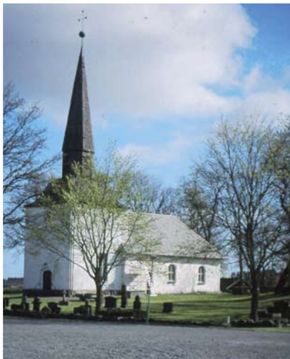
Bild 4. Vy av Gillstad kyrka i Örslösa pastorat, Lidköpings kommun, Västergötland. Kyrkans äldsta delar är från mitten av 1200-talet. Under de renoveringar och ombyggnader som kyrkan har genomgått har man konsekvent behållit de äldre putslagren vilket gör kyrkan till ett unikt källmaterial. Man kan koppla putslagren till de i arkiven dokumenterade ombyggnads- och renoveringsarbeten som byggnaden har genomgått och därmed få en tidsbestämning på putslagren.
