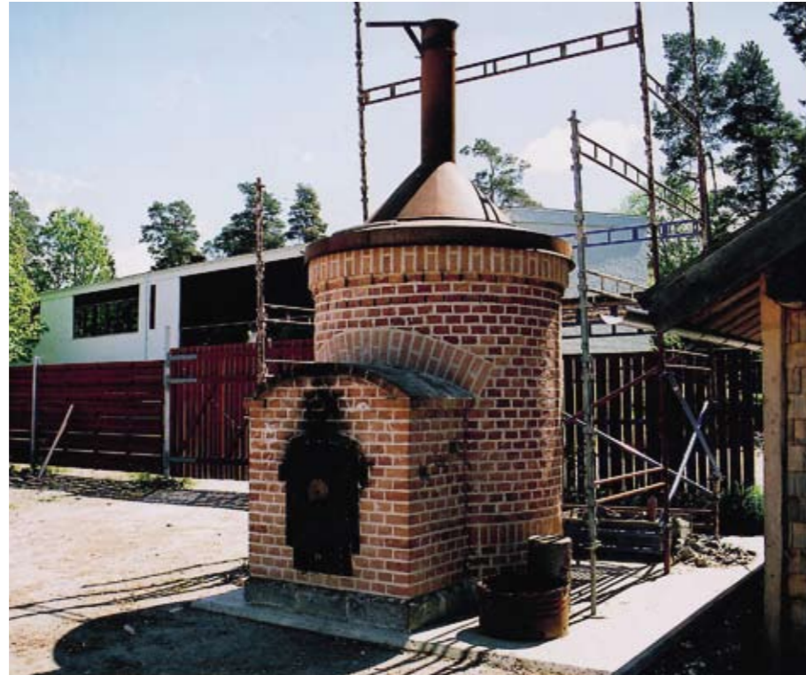
Bild 7. Gamla kalkugnen. Bild på den ugn som uppfördes 2004 och står på byggövningsgården, Johannesberg, Mariestad.
