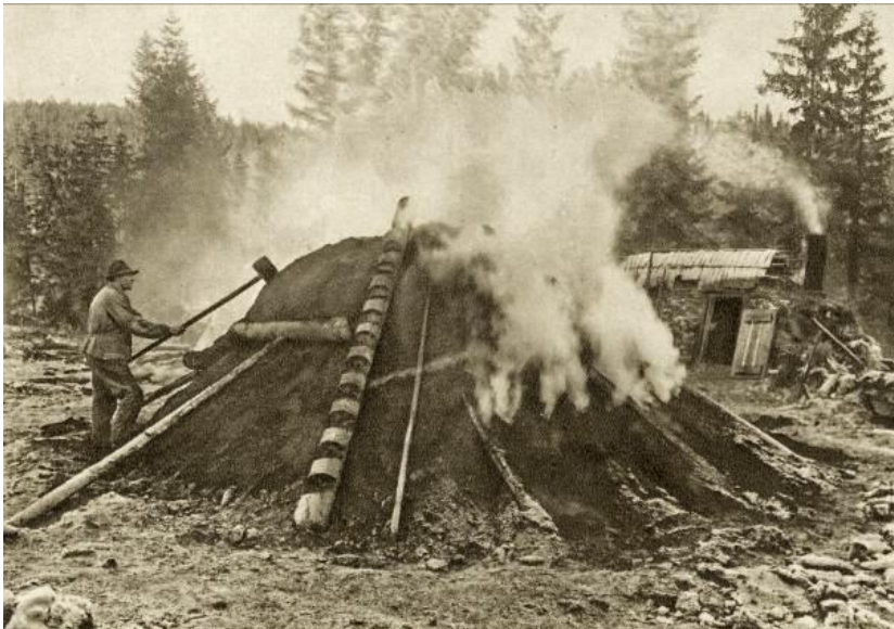
Figur 16. Bilden är tagen vid samma tillfälle och på samma mila som figur nr. 12 och 14. Denna bild är dock tagen från sydost mot nordväst.
