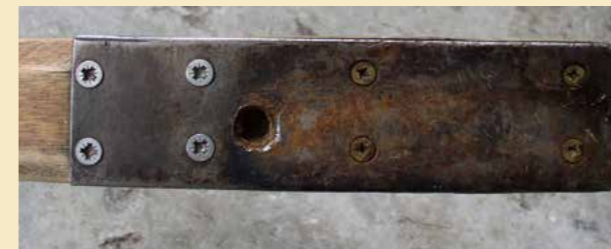
Fäste som blivit förstärkt med en plåtskiva runt tapphållet. Anledningen var att bladtypen orsakade sönderslitning av tapphållet
