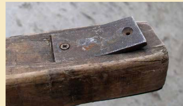
Fäste som blivit förstärkt med plåt på ovansidan för att skydda mot ringens skruv. Tyvärr deformeras detta pga det stora trycket.
