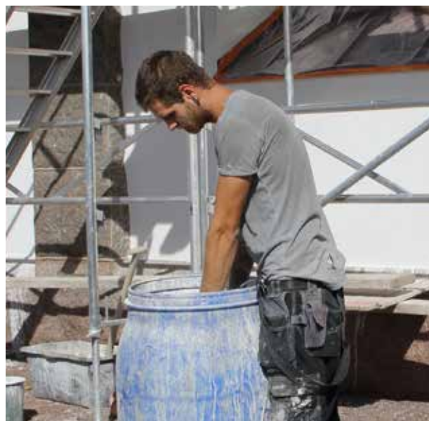
Pigmenten sedimenterar lätt i tunnan och vid varje påfyllning av arbetshinken ska färgen vispas upp. Foto: Arja Källbom.
