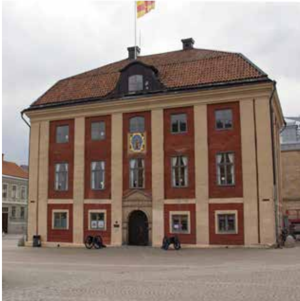
Gamla Rådhuset i Jönköping målades med vattenglasfärg 1978. Analys visade att den tidigare avfärgats med ren silikatfärg, troligen på 1930-talet. Fasaden är fortfarande i bra skick även om den behöver tvättas. Ljusa fläckar är rinningar från bl.a. fönsterfärg på utskjutande mur och består inte av vattenglasfärg. Foto Arja Källbom.
