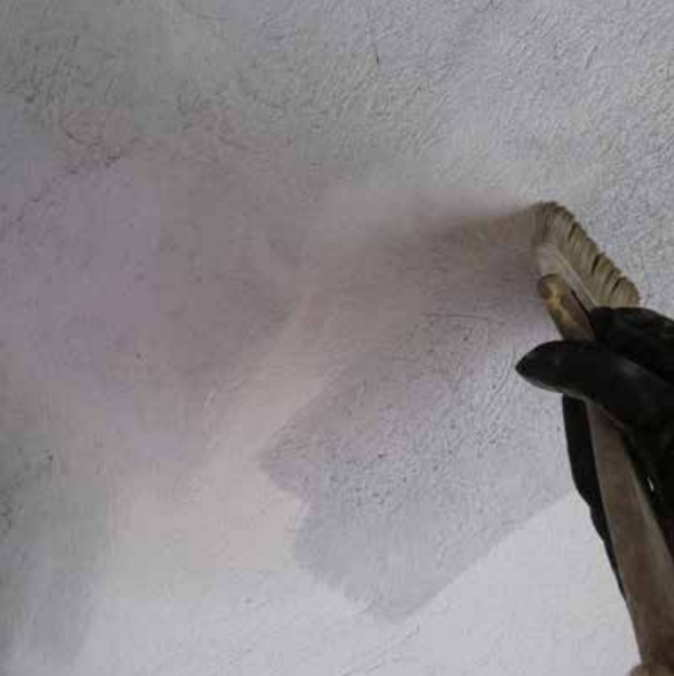
Vattenglasfärg fungerar bra att lasera med. Foto: Arja Källbom.
