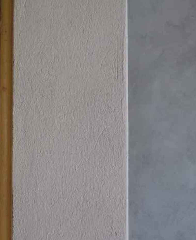
TVå ytor med täckmålad respektive laserad kalkputs. Foto: Arja Källbom.
