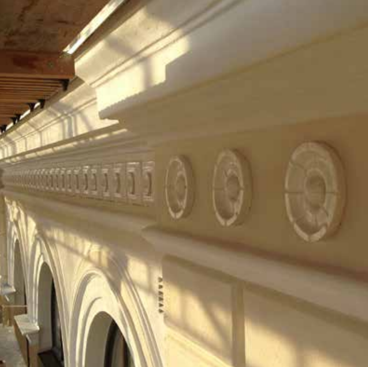
Detaljbild från Malmö Centralstation, 2014. Vattenglasfärg på naturligt hydrauliskt bruk. Foto: Tor Ek.
