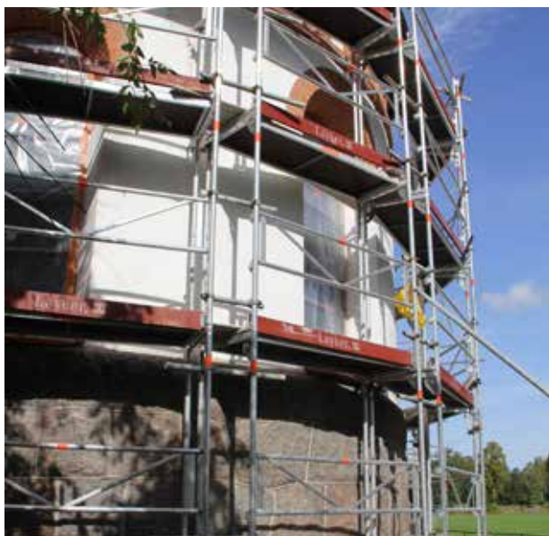
Fönsteröppningarna är skyddstäckta, men inte stengrunden som blästrades efter avslutat arbete. Foto: Arja Källbom.
