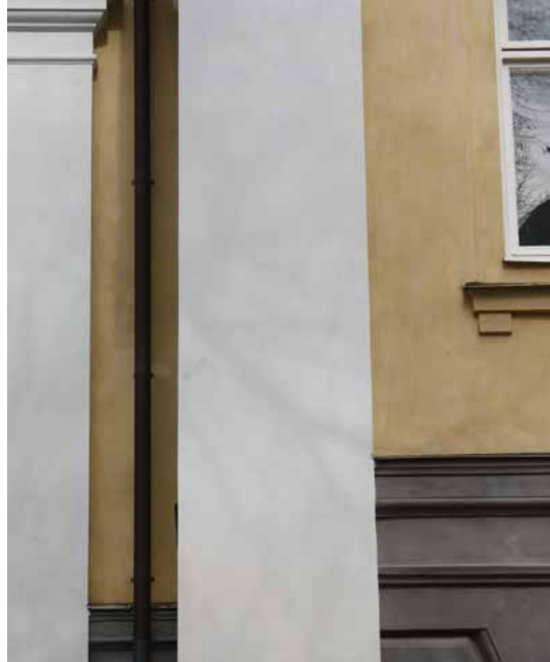
Per-Brahe gymnasiet i Jönköping har en relativt livfull vattenglasfärgsmålad fasad. Foto Arja Källbom.
