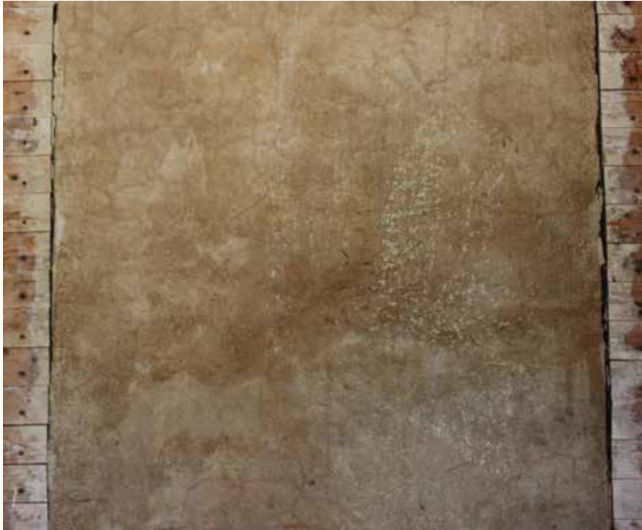
Mönster i murverket efter grundning. Kornen är ungefär 3-10 cm. Foto: Arja Källbom.
