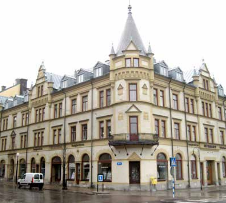
Många byggnader i Sundsvall är målade med vattenglas- och silikatfärg, bland annat hörnfastigheten, Storgatan 2. Foto: Lars-Erik Sjöberg.
