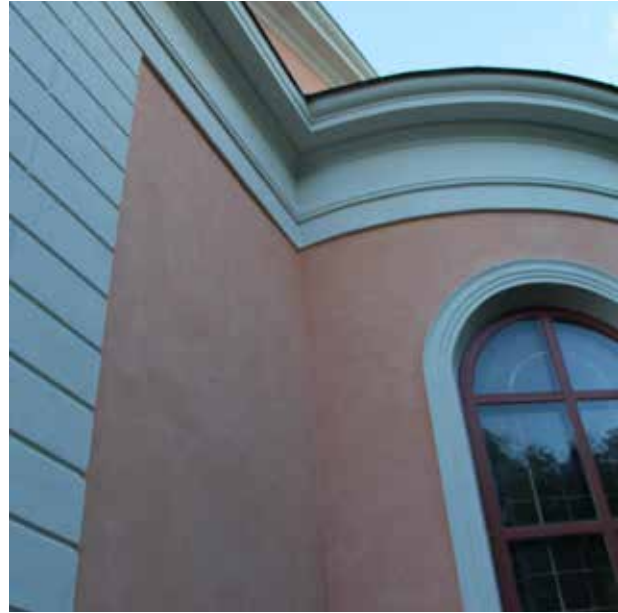
Barkeryds kyrka efter att den putsades och målades 2012 (Franzén, 2012). Kulören ändrades något. Foto: Arja Källbom.
