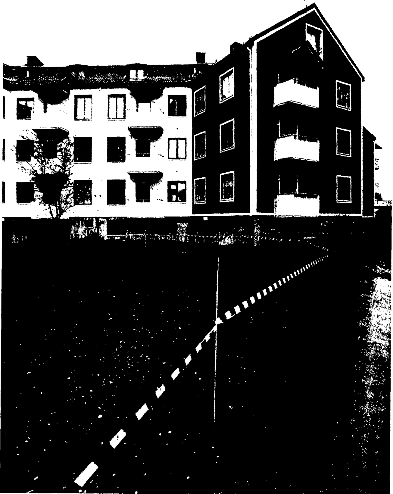
De exteriöra förändringarna var relativt små efter ombyggnad, åtminstone sett från husens baksida.
