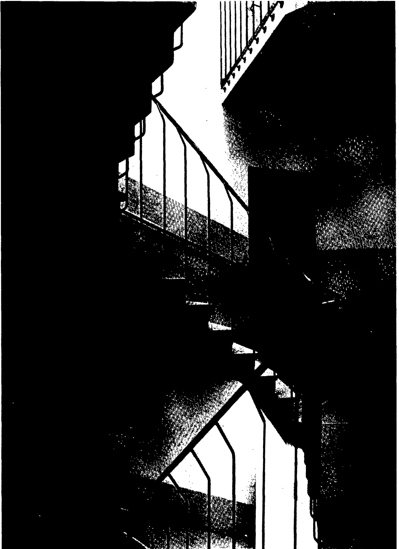
Den öppna spindeln med trappstegen inspända i väggen gör det ovanligt lätt att här minska trappbredden och få plats med en hiss.
