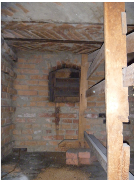
(Samtliga bilder ovan) Knäckebrödstork med murat valv och murade konsoler för brödkäppar
