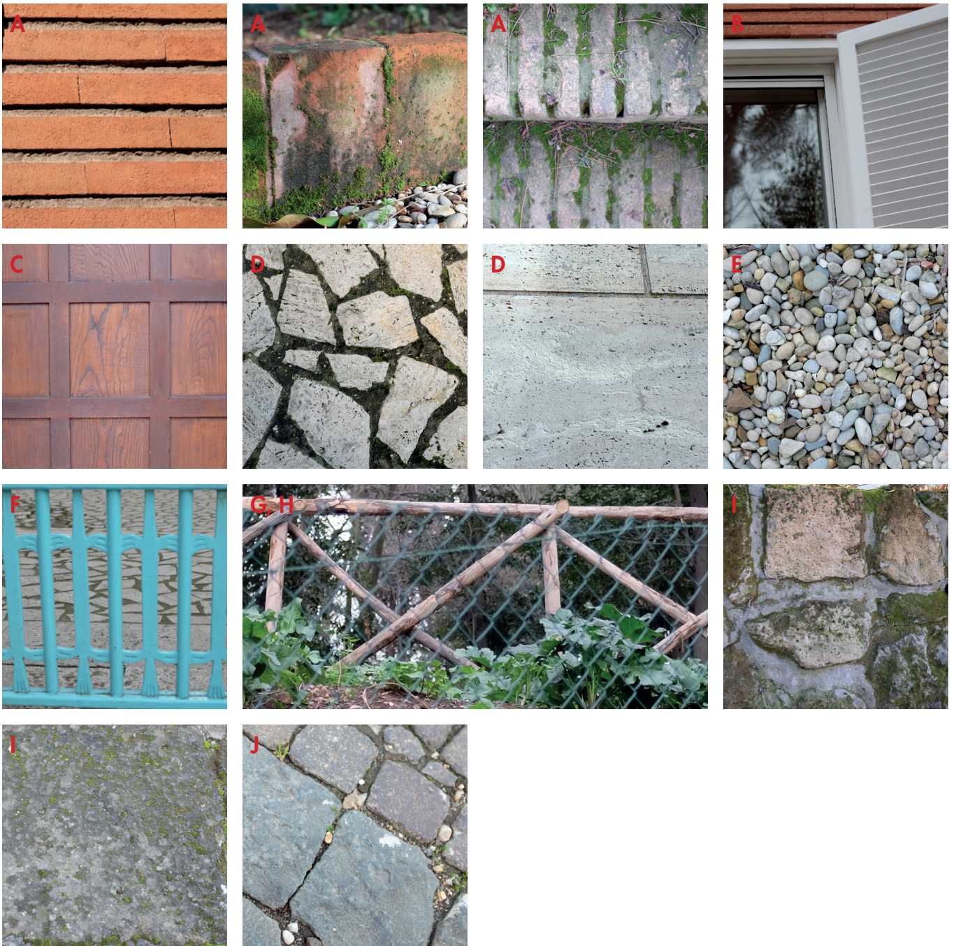
Figur 55. Samma grundmaterial som har fått olika dimensioner eller ytbehandlingar. Varianter på tegel, travertin, tuff, stål och trä.
