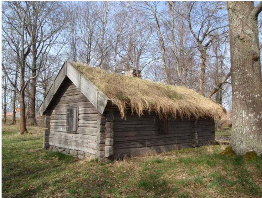
Figur 1. Torvtak på byggnad i Alhagen, Mariestad.
