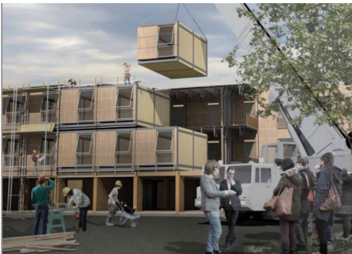
Figur 10. Modulbostäderna monteras med kran (Hagy, 2014, s 80)
