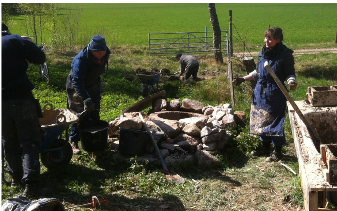
Figur 22. Stationen för adobeblock med nästan samtliga moment i bild. Grävning, bråkning, vattenhämtning, badkaret att blanda i och formar att slå blocken i. Deltagarna började att gräva lera och bearbeta med vatten för att sedan blanda det med halmen och sågspånet för att sedan slå block i de nya
