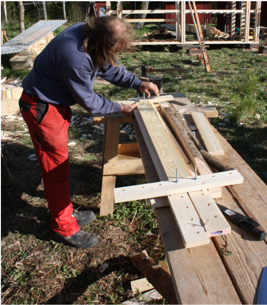
Figur 27. En person gav sig hän åt att tillverka en mall för att borra hål i bälarna. Denna person använde hålsystemet till fullo då själva mallen gjordes inom ramen för vad hålen tillät. Samtidigt så prövade några andra att borra bälarna på plats i konstruktionen. Detta visade sig leda till problem då måttet för hålen inte längre följde avståndet 67,5 mm och hålsystemet sattes ur funktion. Foto: Gunnar Almevik
