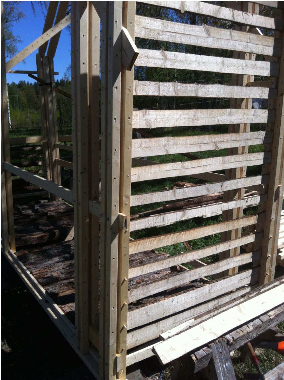
Figur 29. Bålarna sattes fast med träplugg. Dessa skulle sedan utgöra läkt för takspånet. Sågbakar utgör trossbotten.
