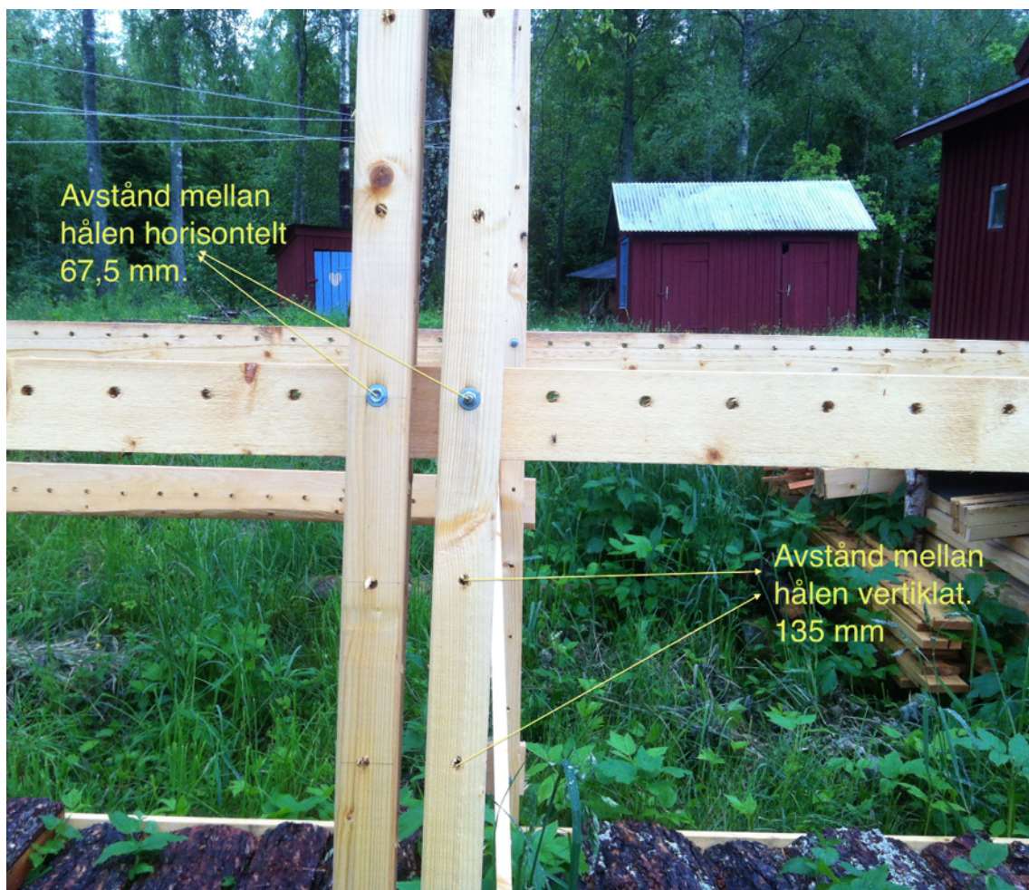
Figur 16. Detta är den slutgiltiga principen för håltagningen där jag tog bort halva antalet hål som är på figur 15. Centrumavståndet mellan varje hål blir vertikalt 135 mm och horisontellt 67,5 mm. Spåret är 22,5 och passar mot virket som var 22 mm. Att antalet hål är det dubbla horisontellt beror på att stolparna står vertikalt och ska kunna anslutas från båda håll av en sektion. 135 mm horisontalt var också ett lämpligt avstånd för spånläkt. Samt att det hade gått att fylla halmen mellan bälarna utan att det hade ramlat ut särskilt mycket. Detta skulle sedan kunna vara en möjligt putsbäare.
