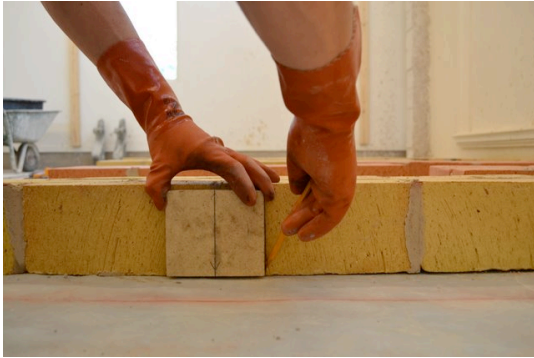
Avståndet för placeringen av L-järnen mättes ut med en tolk. Strecket på tolken centrerades över fogen enligt bilden.
