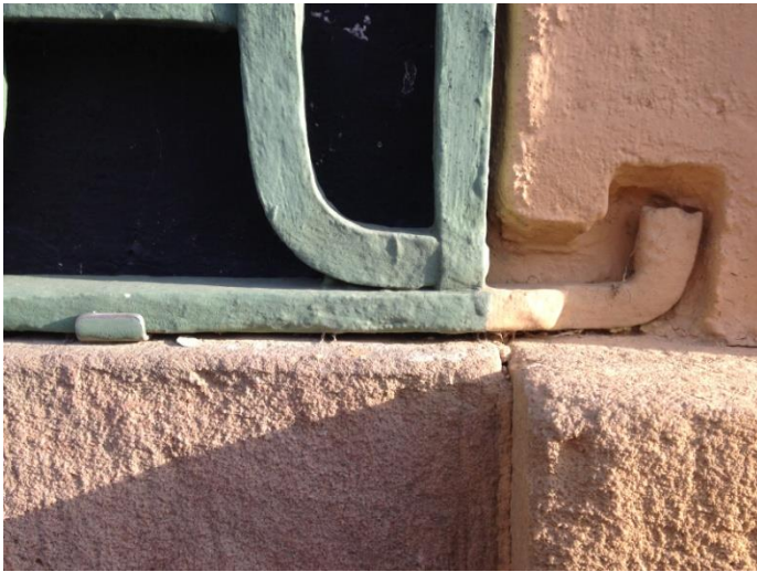
Fig. 10 & 11. T.v fönstergallrens originalinfästning, synlig. T.h fönster i sin helhet.
